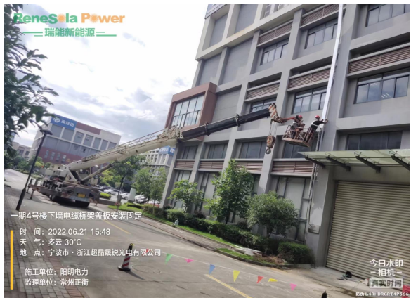
下墙电缆桥架盖板安装固定
