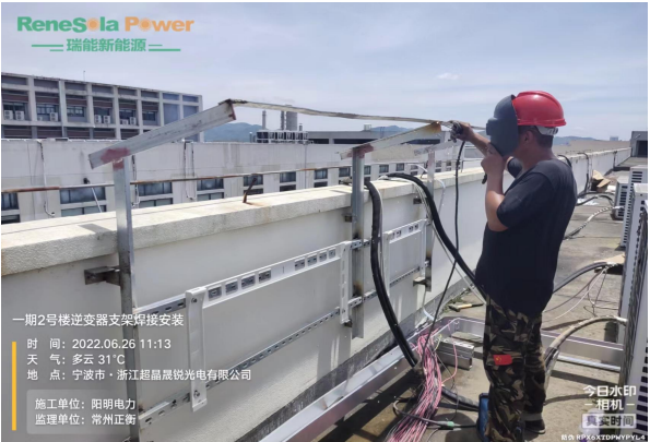
光伏逆变器支架焊接固定
