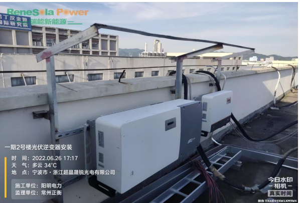
光伏逆变器安装固定
