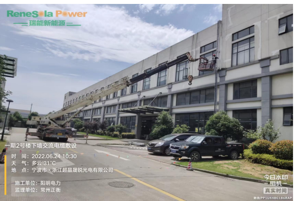
下墙交流电缆敷设
