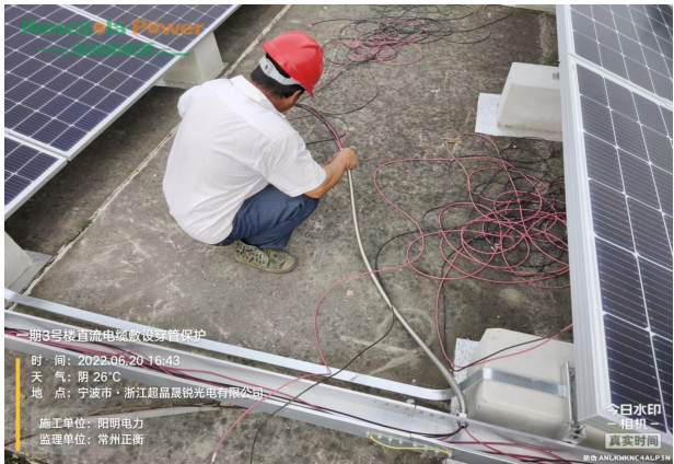
直流电缆敷设穿管保护
