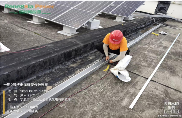
电缆桥架分散连接
