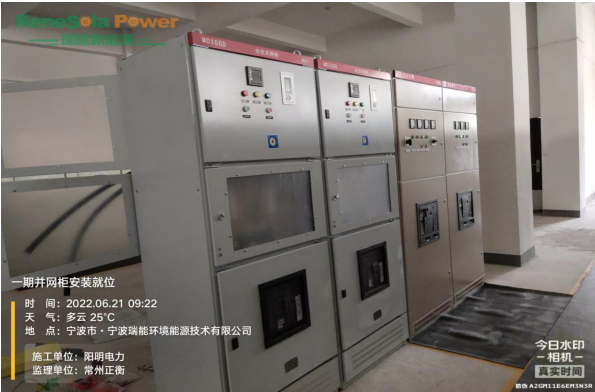
配电房并网柜安装就位
