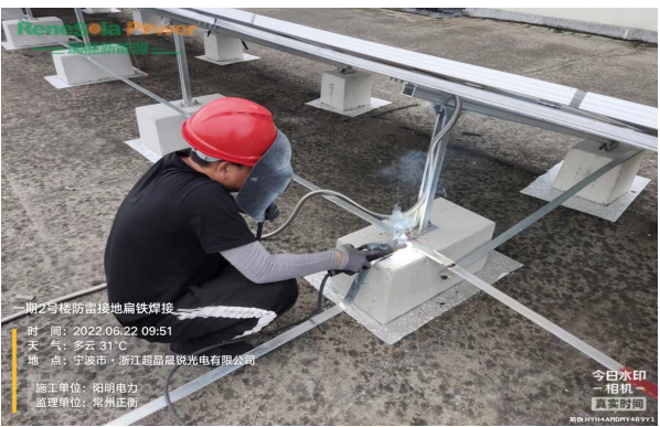
防雷接地扁铁焊接
