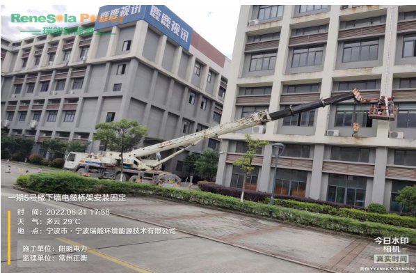
下墙电缆桥架安装固定
