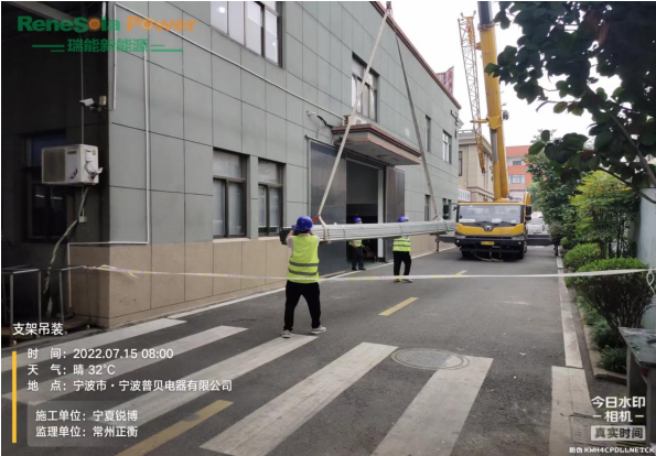
光伏支架吊装
