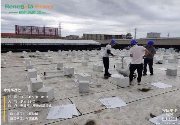
水泥墩倒运摆放
