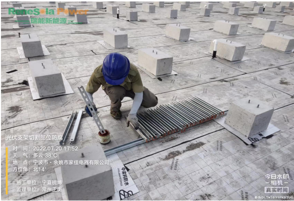
光伏支架切割部位防腐
