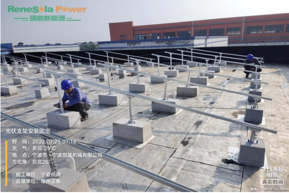
光伏支架安装固定
