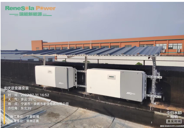
光伏逆变器安装
