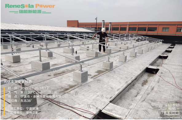
光伏支架安装检查
