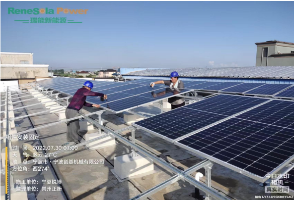
组件安装固定
