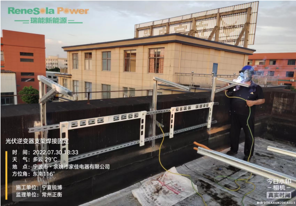
光伏逆变器支架焊接固定
