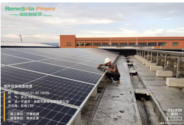
组件安装角度检查
