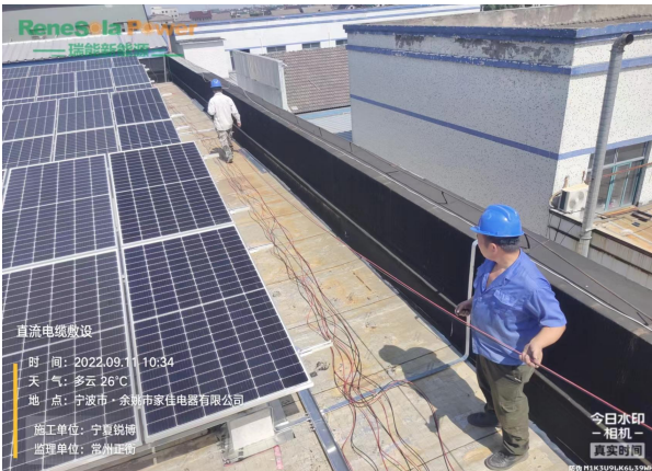
直流电缆敷设
