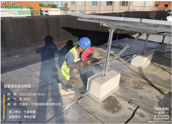
防雷接地扁铁焊接
