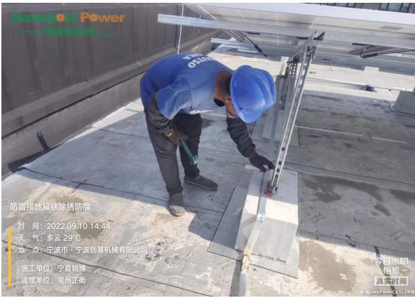
防雷接地扁铁除锈防腐
