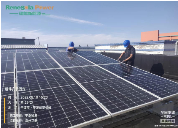
组件安装固定
