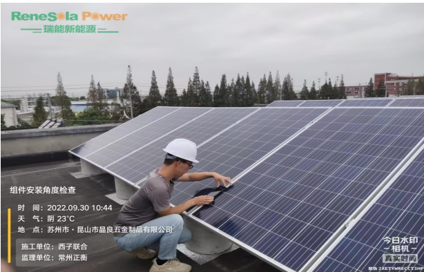
组件安装角度检查
