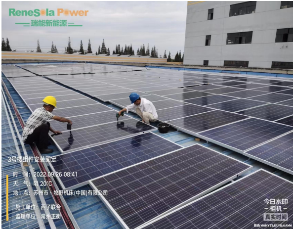
组件安装固定
