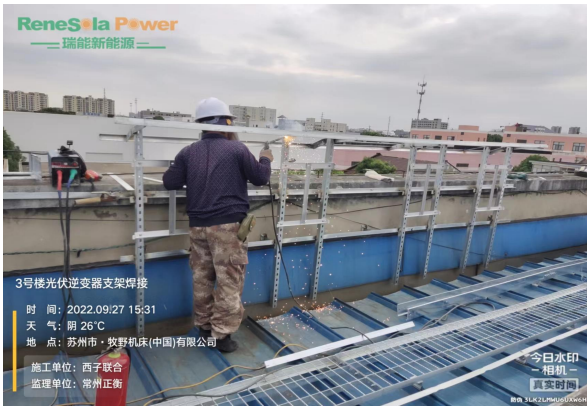
光伏逆变器支架焊接固定
