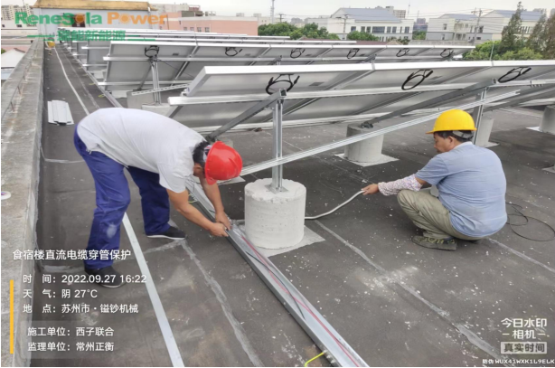
直流电缆穿管保护
