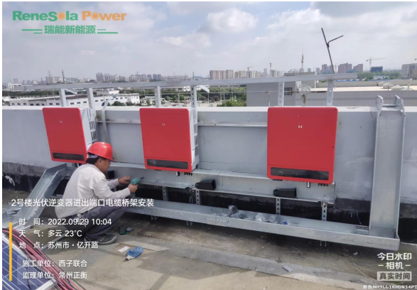
光伏逆变器进出端口电缆桥架安装
