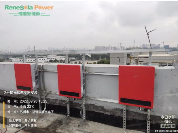
光伏逆变器安装
