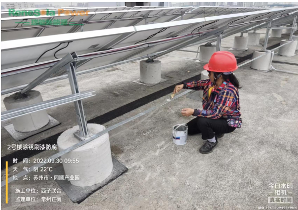
防雷接地扁铁除锈刷漆防腐
