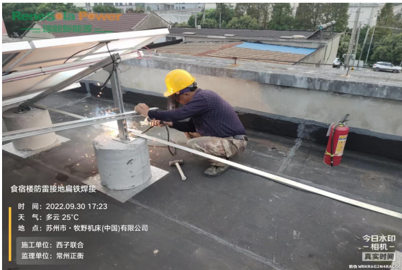
防雷接地扁铁焊接
