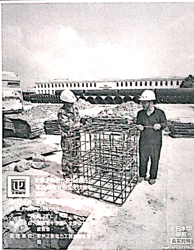
欧波厂区车棚基础钢筋笼检查
