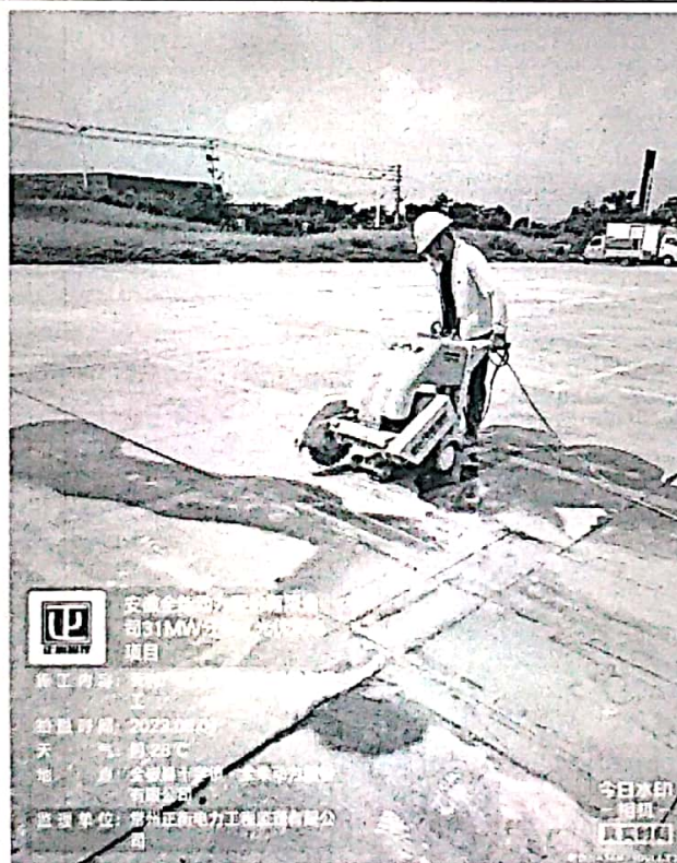
天利厂区车棚基础地面切割施工
