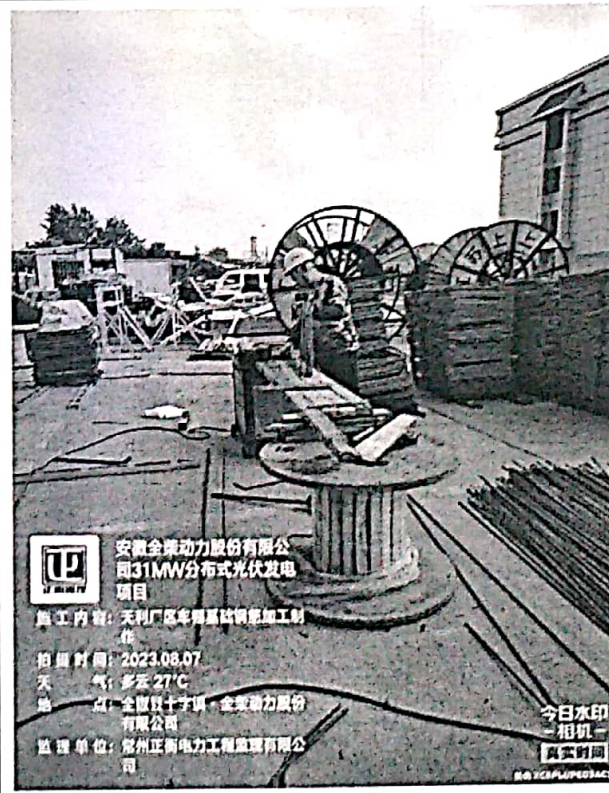
天利厂区车棚基础钢筋加工制作
