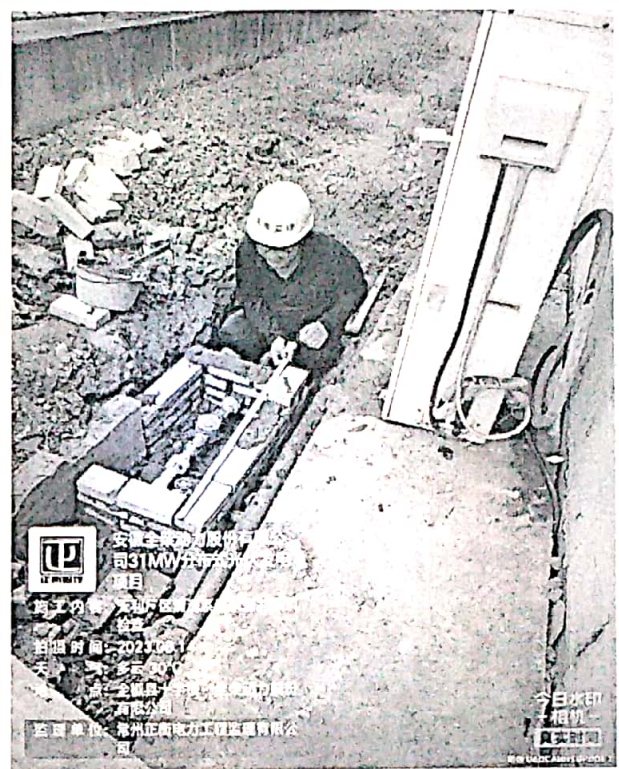
天利厂区清洗系统水表井砌筑检查
