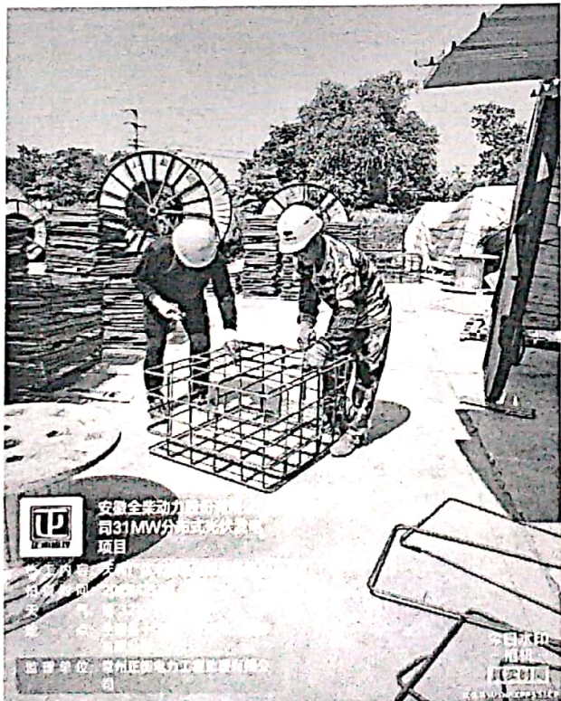
天利厂区车棚基础钢筋笼绑扎
