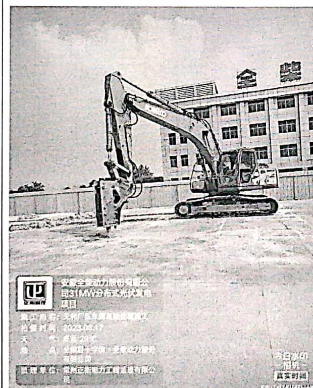
天利厂区车棚基础挖掘施工
