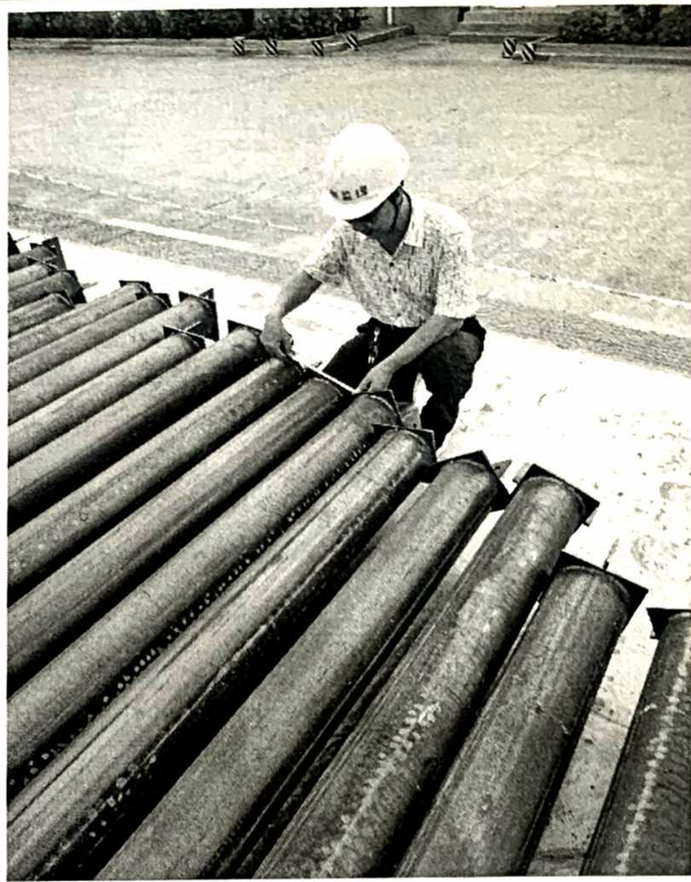
进场材料检查
