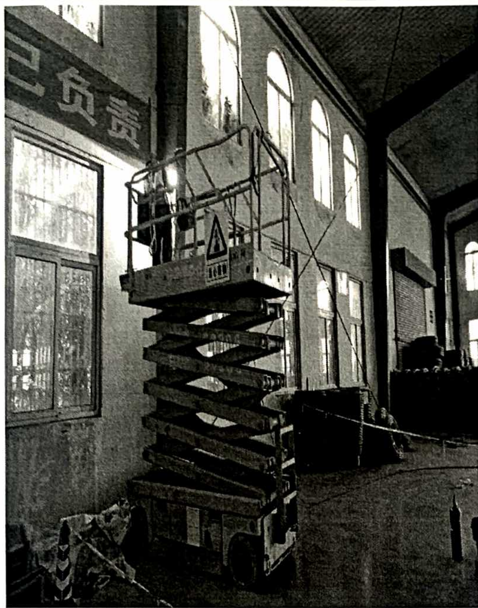
欧波厂区立柱焊接施工
