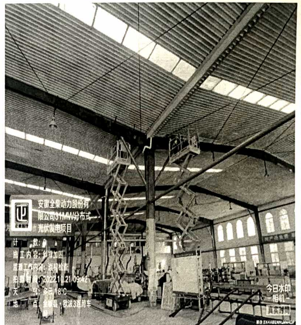
欧波厂区斜撑加固
