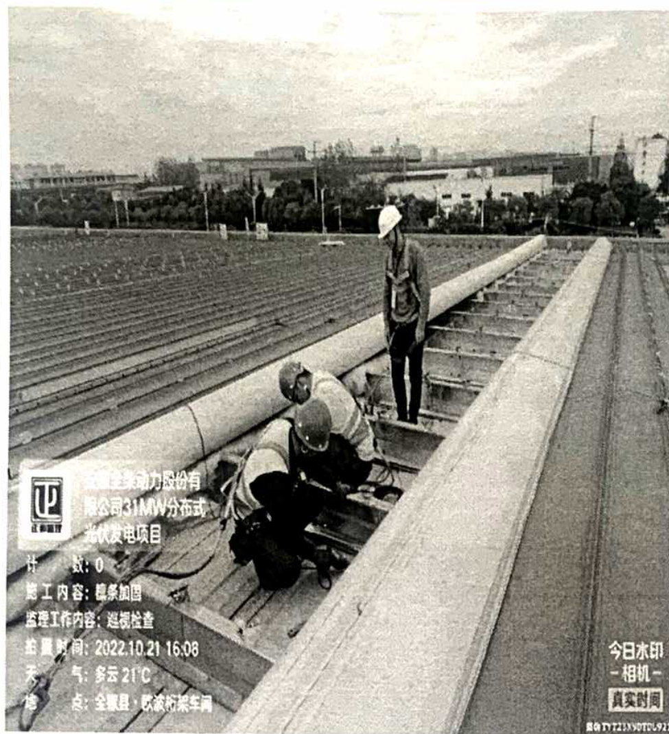
欧波厂区檩条加固检查
