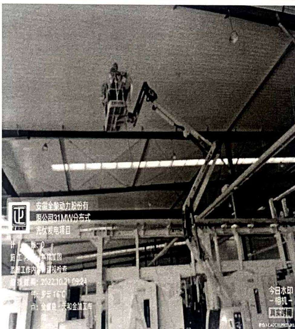
金加工车间斜撑加固安装
