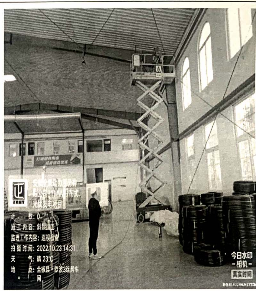
欧波斜撑加固检查
