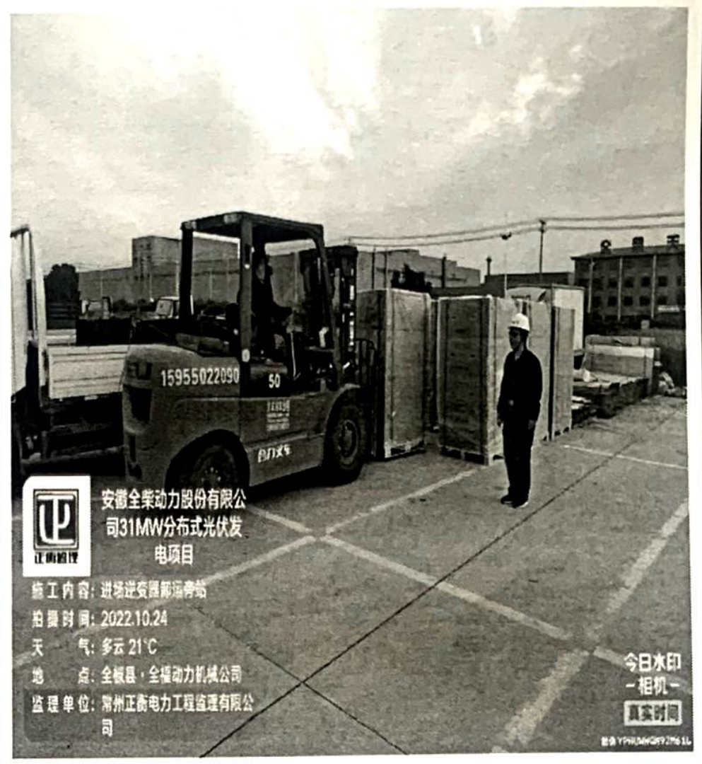
逆变器卸运旁站
