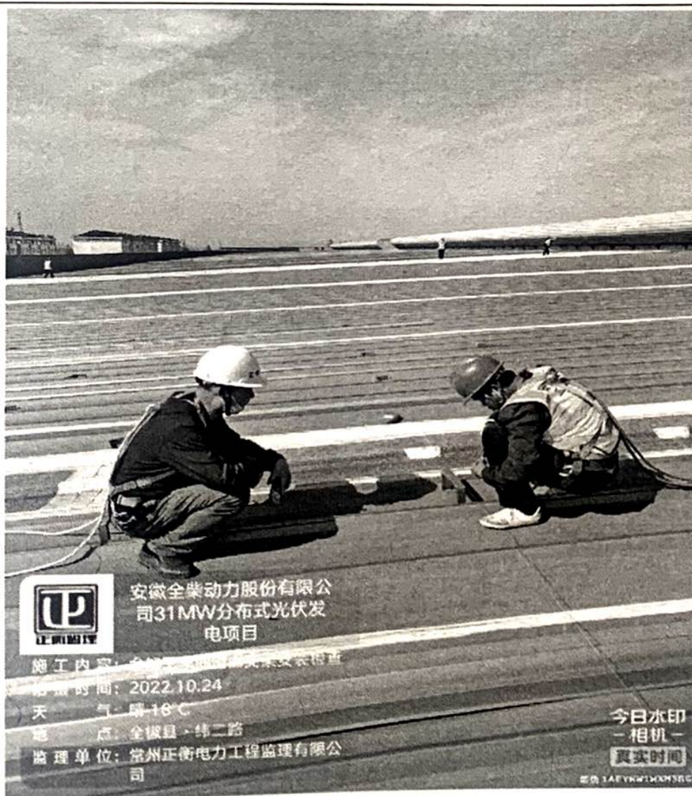
金加工车间支架安装检查
