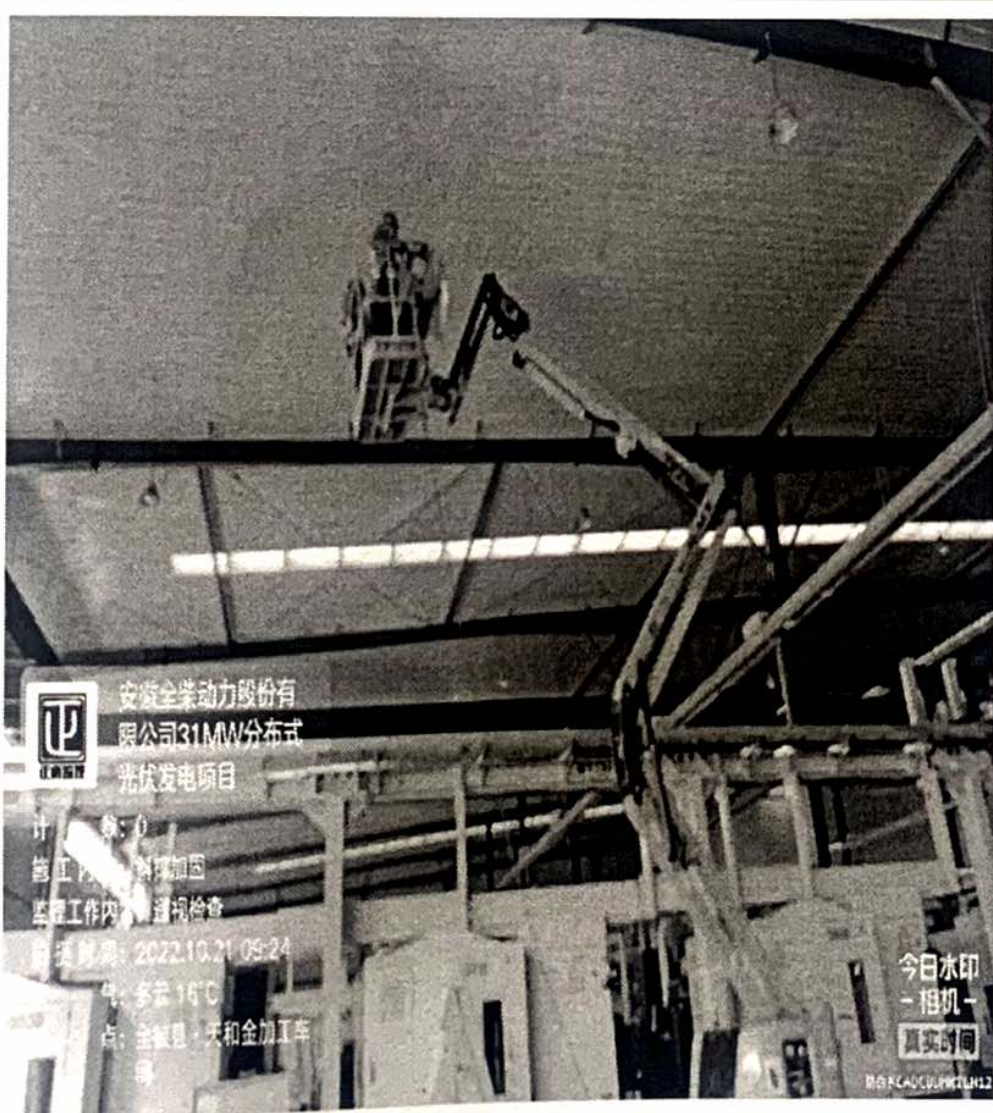
金加工车间斜撑加固安装
