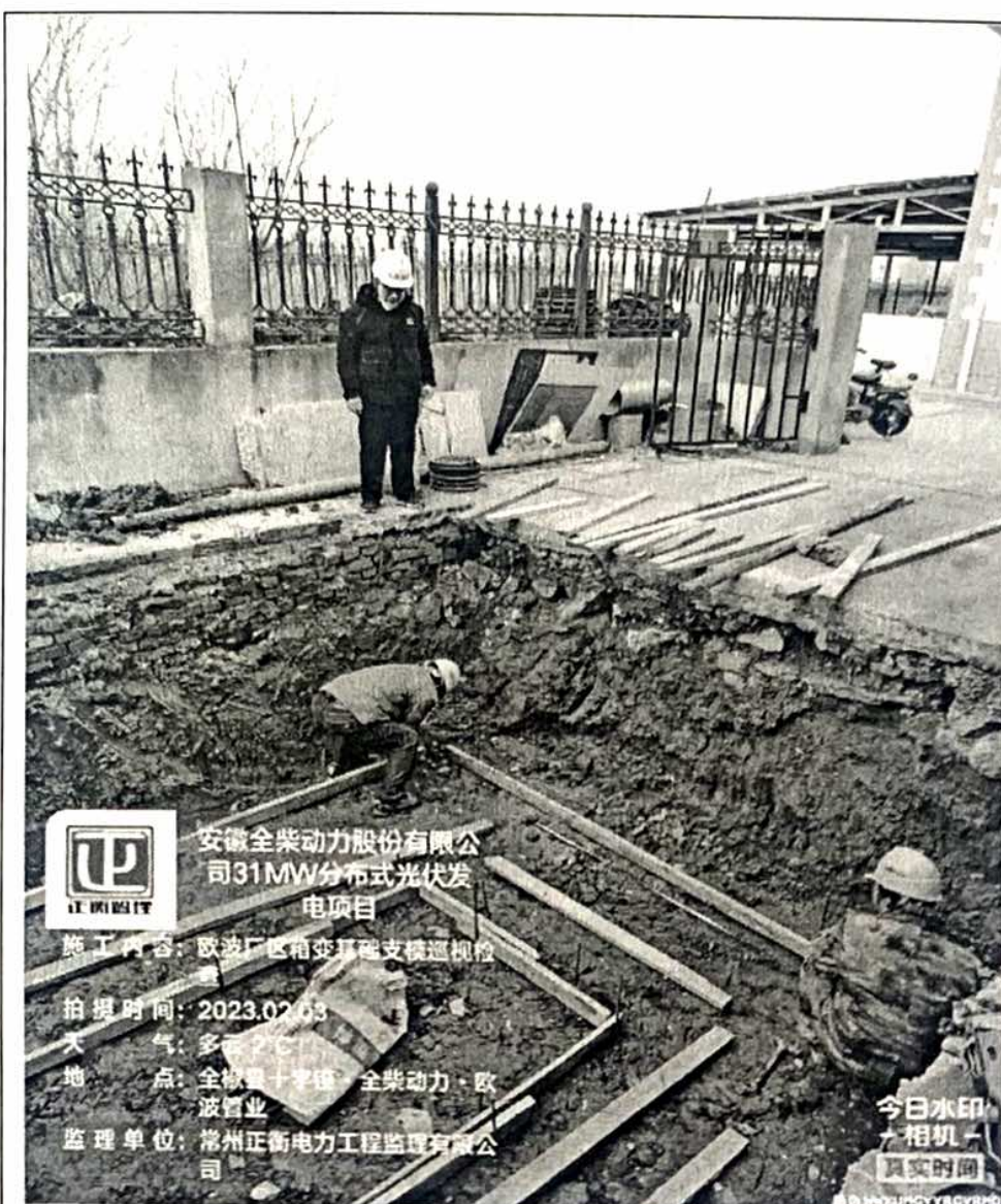
欧波厂区箱变基础支模巡视检查
