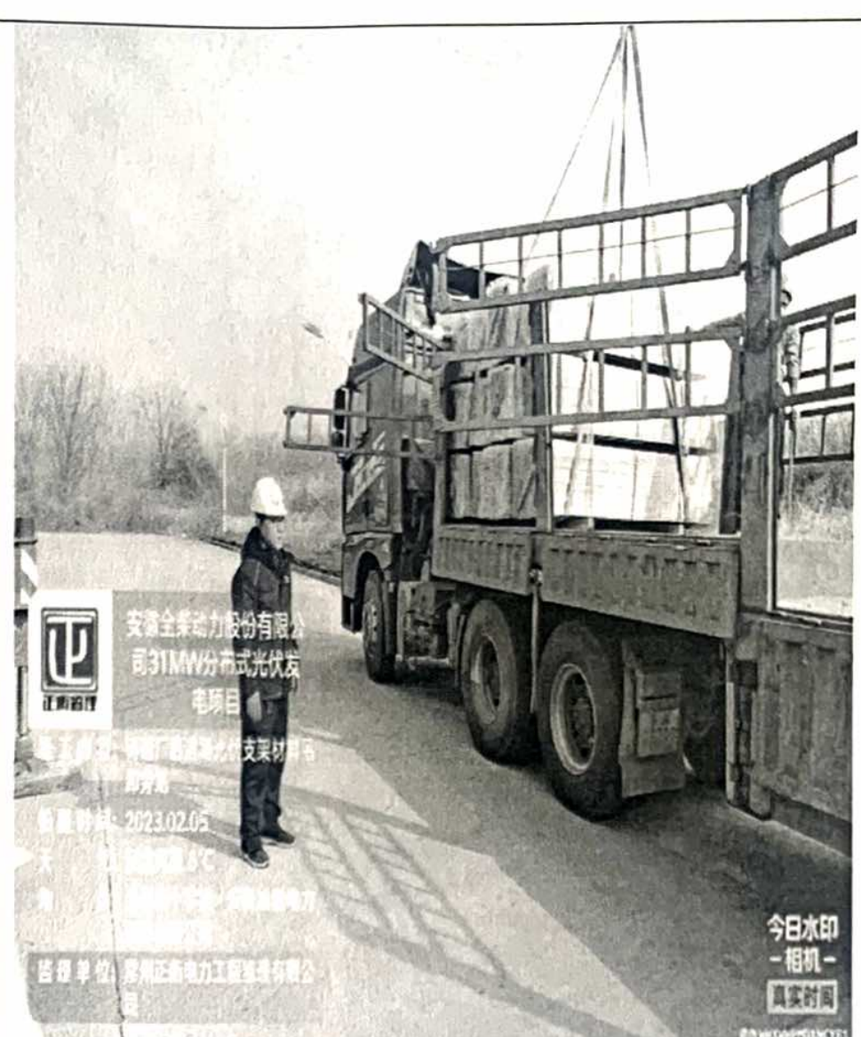
铸造厂区进场光伏支架材料吊卸旁站
