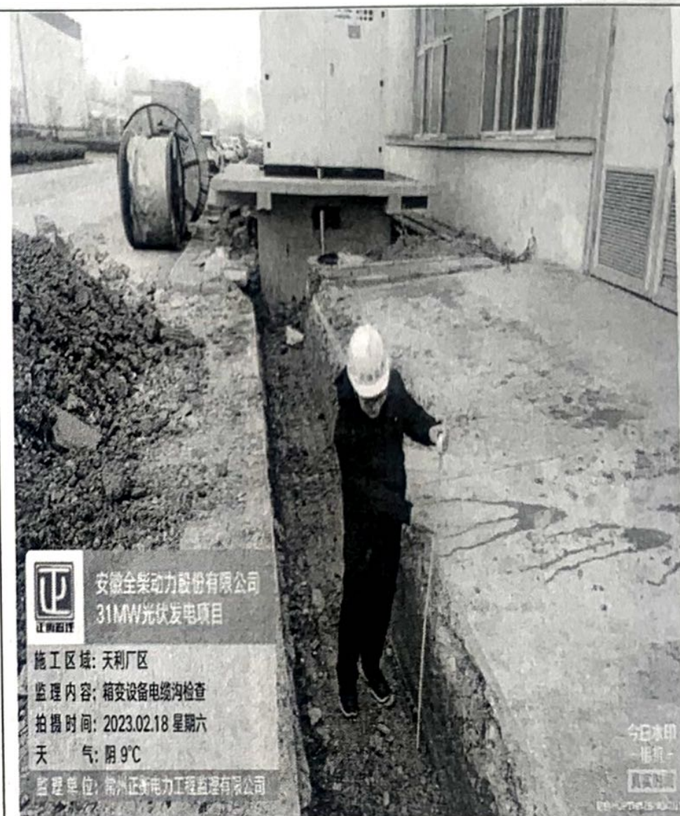
箱变设备电缆沟检查
