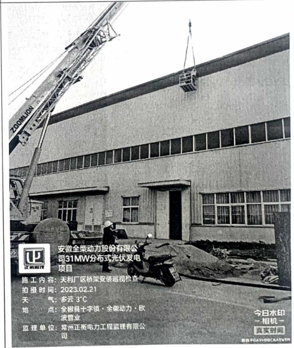
天利厂区桥架安装巡视检查
