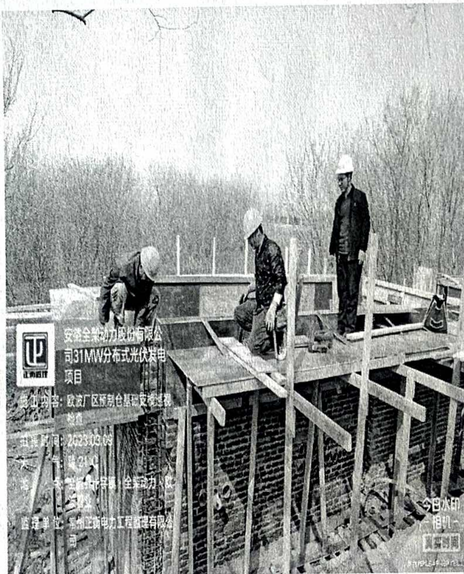
欧波厂区预制仓支模巡视检查
