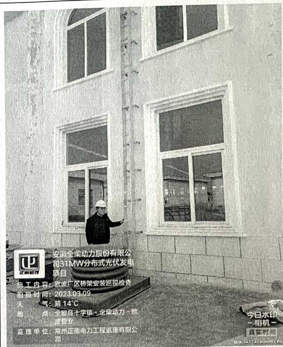
欧波厂区桥架安装巡视检查
