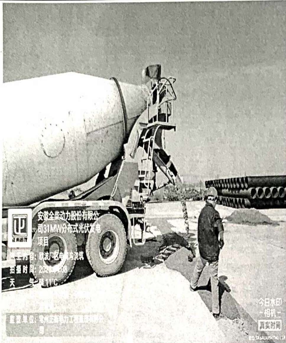
欧波厂区电缆沟浇筑
