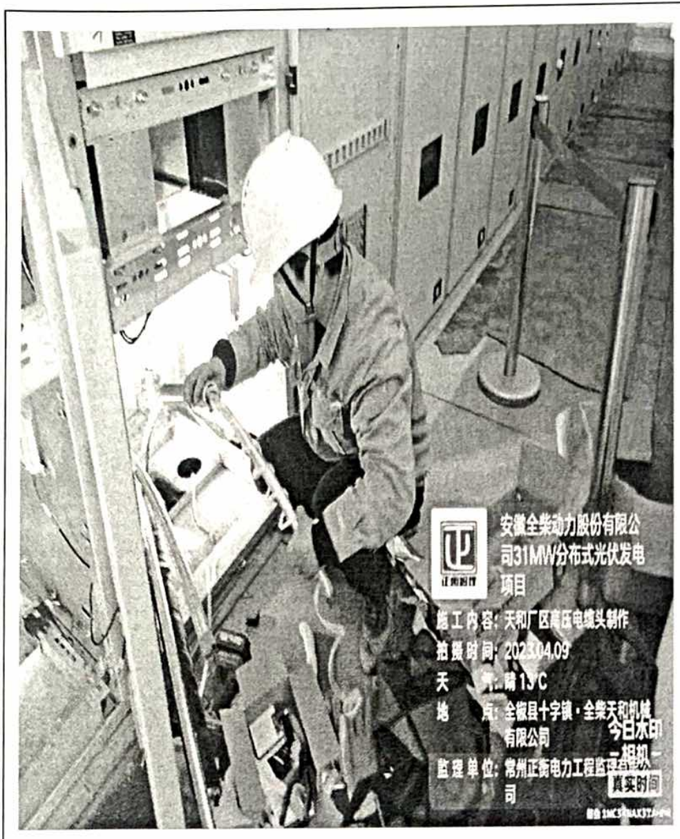
天和厂区高压电缆头制作
