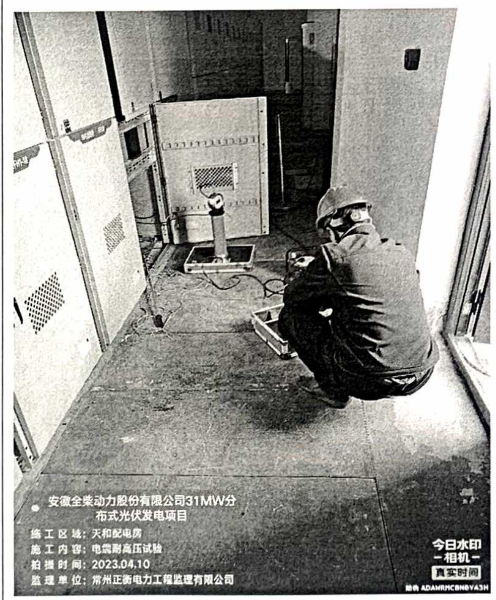
天和厂区耐压试验
