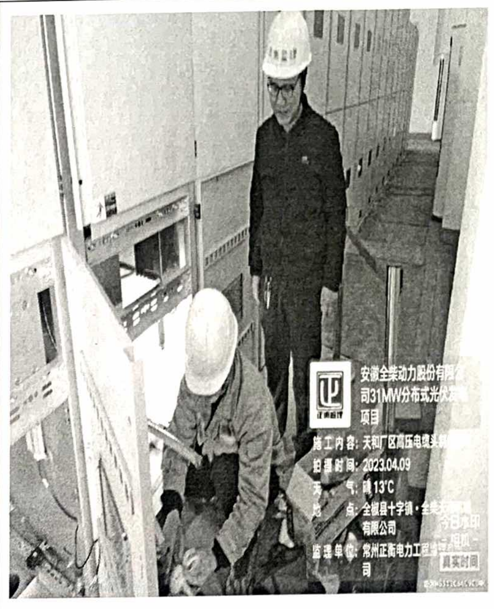
天和厂区高压电缆头制作旁站
