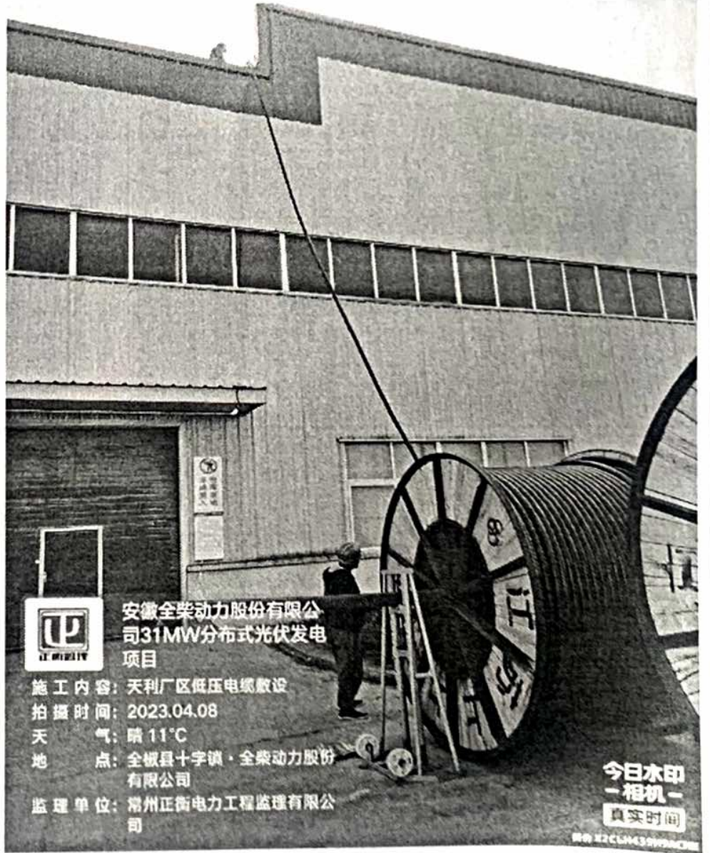
天利厂区低压电缆敷设
