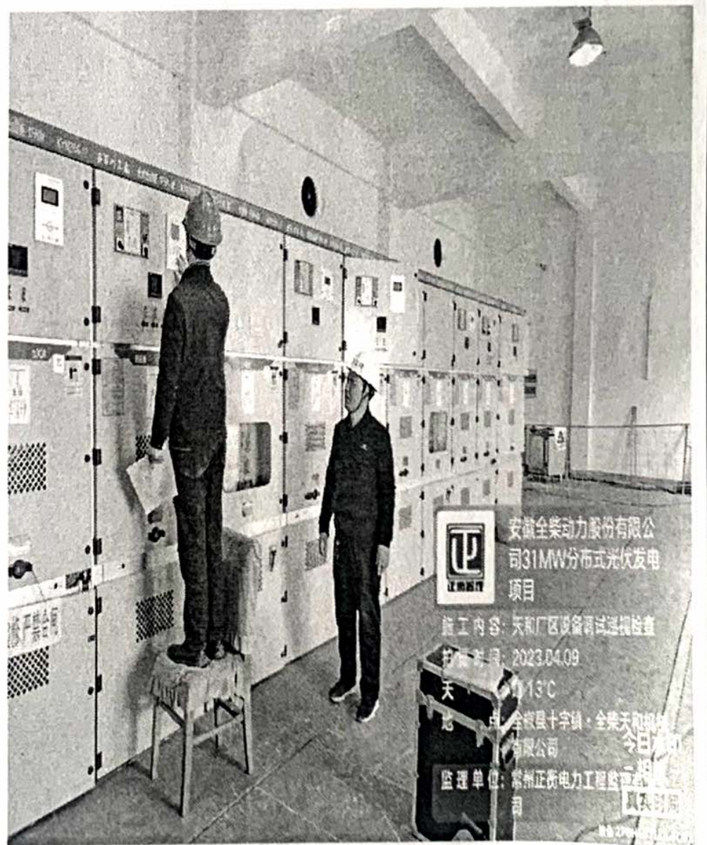
天和厂区设备调试巡视检查
