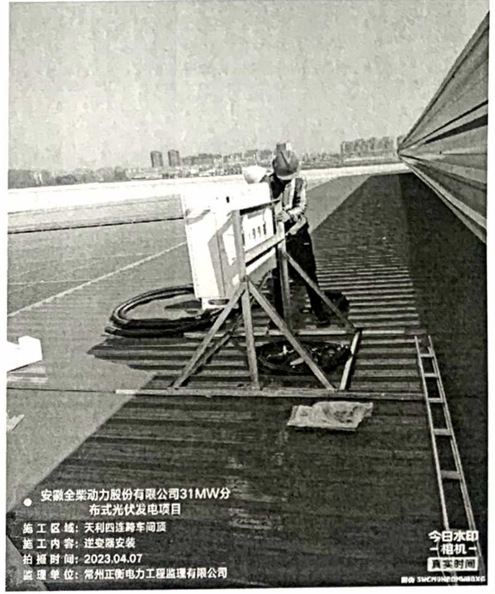
天利厂区逆变器安装
