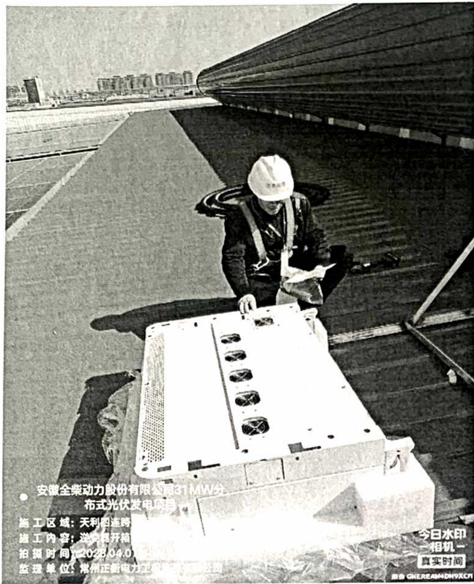
天利厂区逆变器开箱检查
