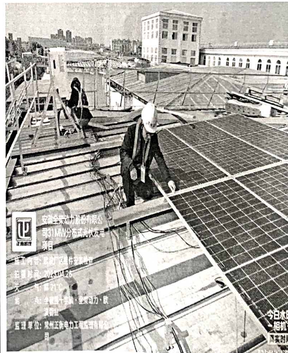
欧波厂区组件安装检查
