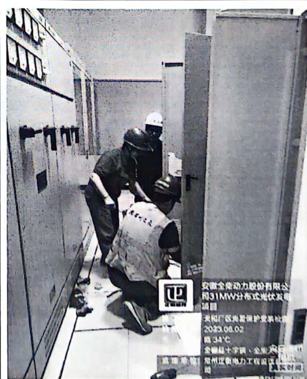
天和厂区光差保护安装检查
