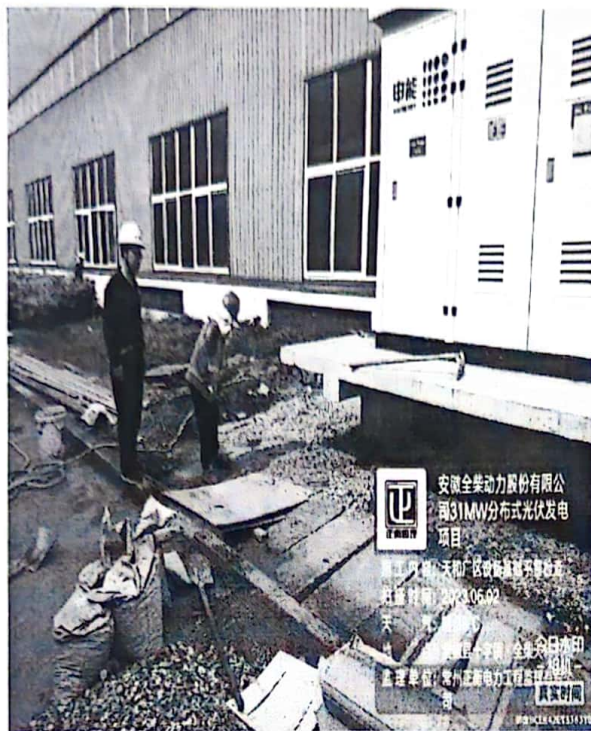
天和厂区设备基础平整检查
