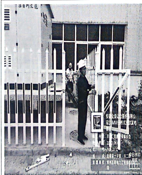
天利厂区围栏安装检查
