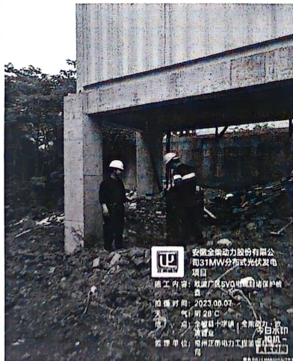
欧波厂区 SVG 电缆封堵保护检查
