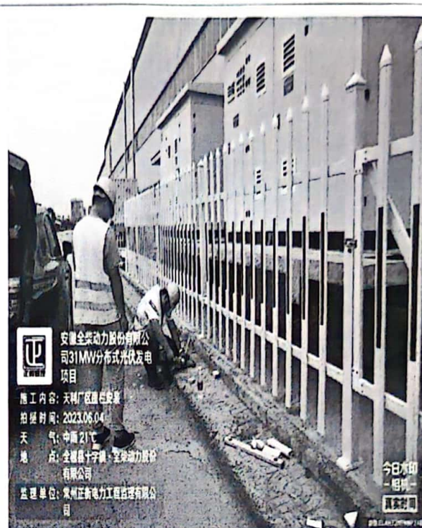
天利厂区围栏安装
