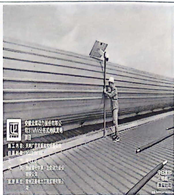
天利厂区屋面监控设备安装
