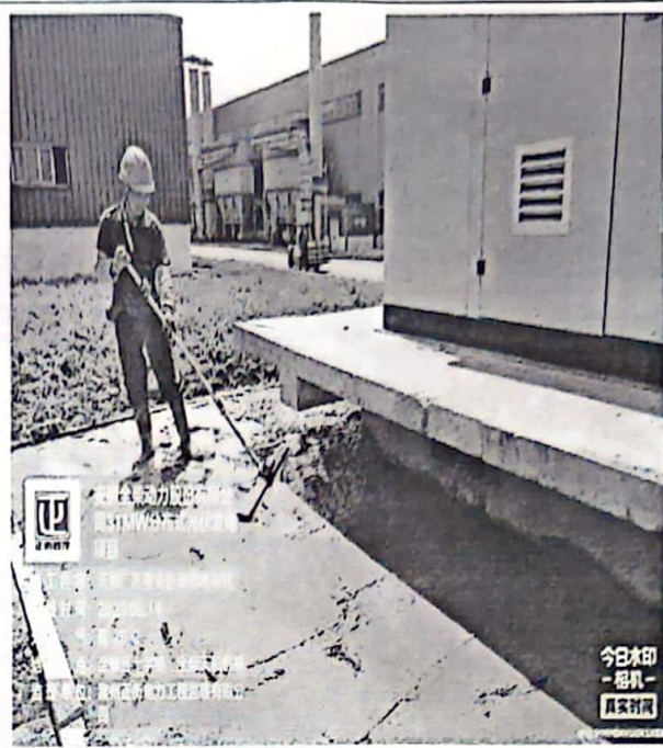
天和厂区箱变基础场地浇筑
