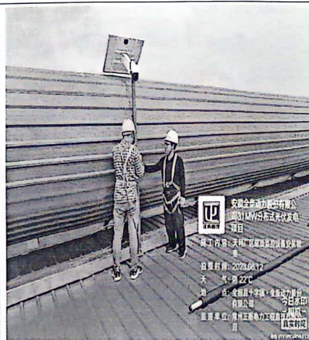
天利厂区屋面监控设备安装检查
