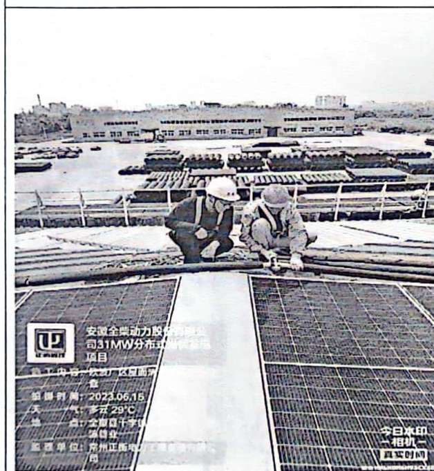
欧波厂区屋面清洗系统安装检查
