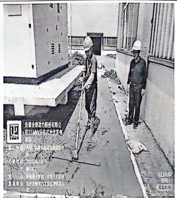
天和厂区箱变基础场地浇筑旁站
