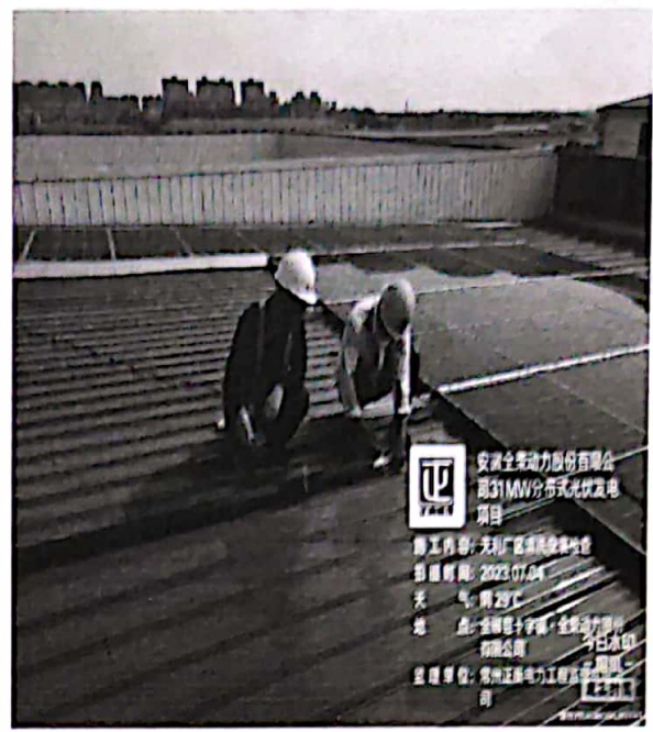
天利厂区清洗系统安装检查
