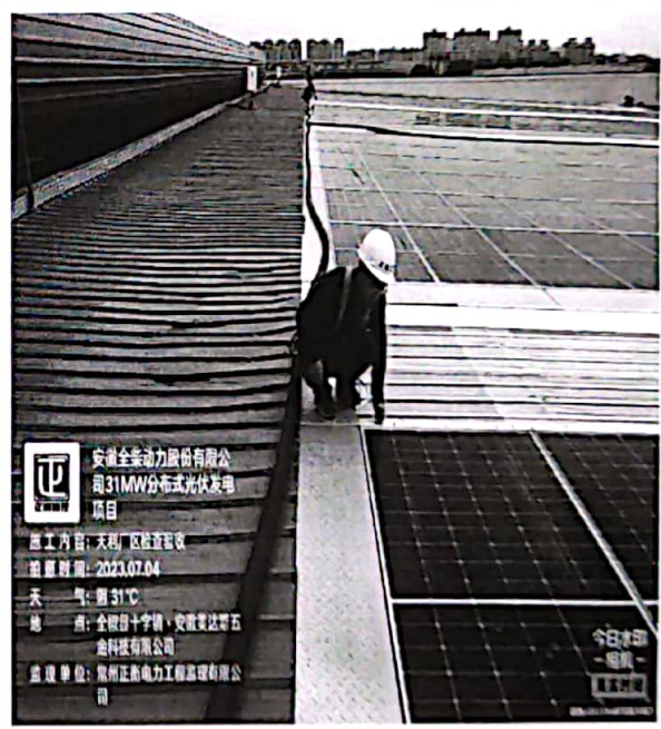
天利厂区组件安装检查
