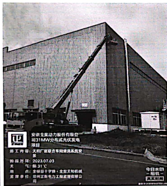
天和厂区清洗系统安装
