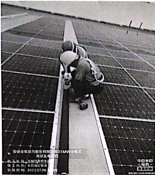
天利厂区清洗系统安装
