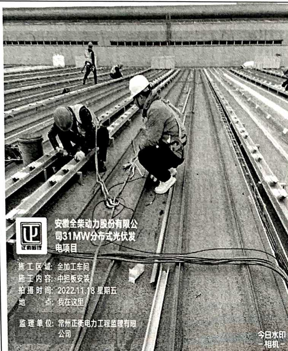
金加工中担板安装检查
