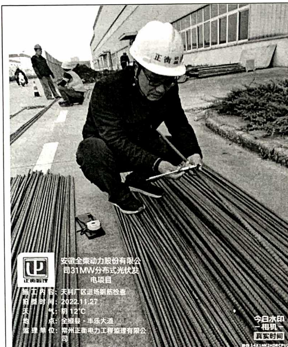
天利进场钢筋检查
