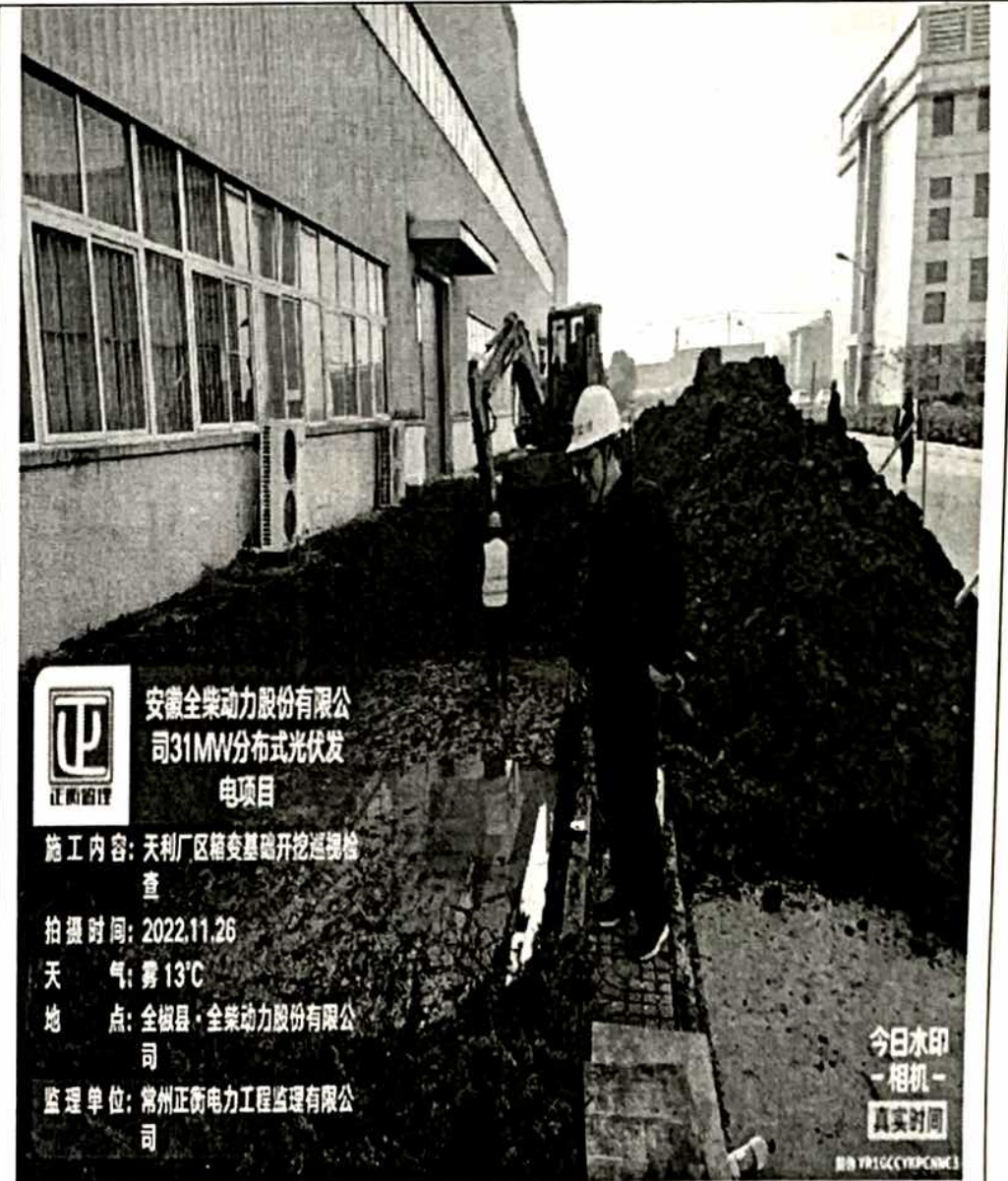
天利箱变基础开挖检查
