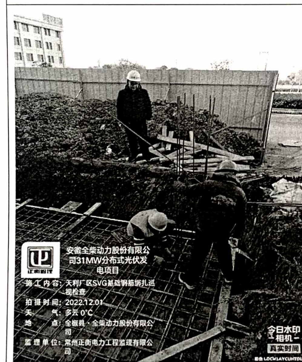
SVG 基础钢筋绑扎检查
