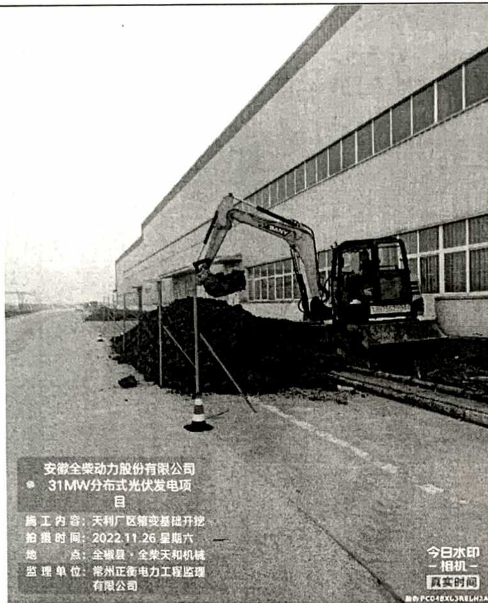
天利厂区设备基础开挖
