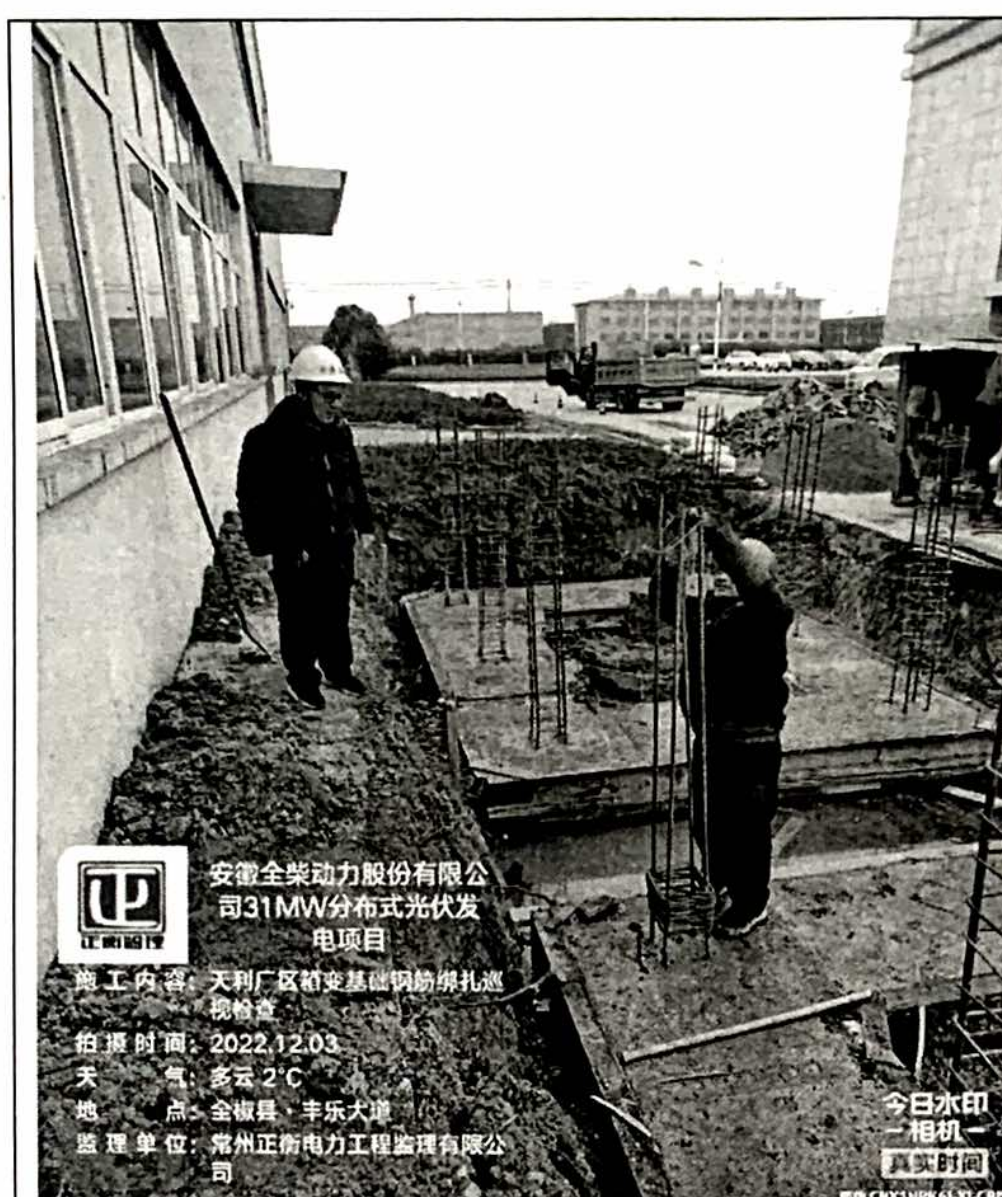
天利箱变基础钢筋绑扎检查
