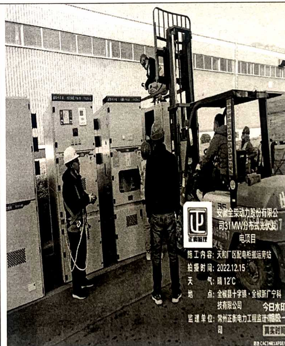
天和配电柜搬运旁站
