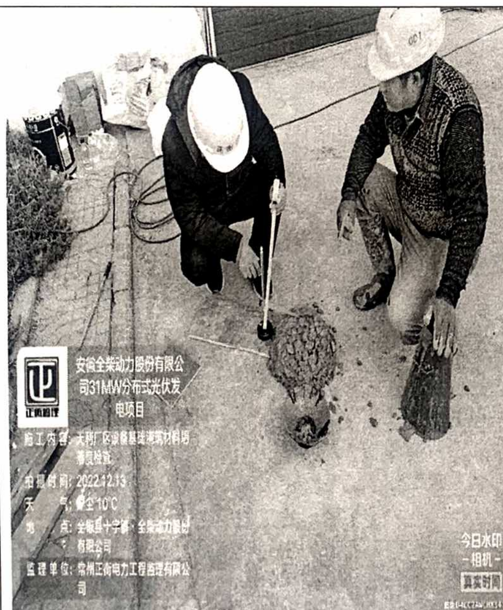
天利浇筑材料塌落度检查
