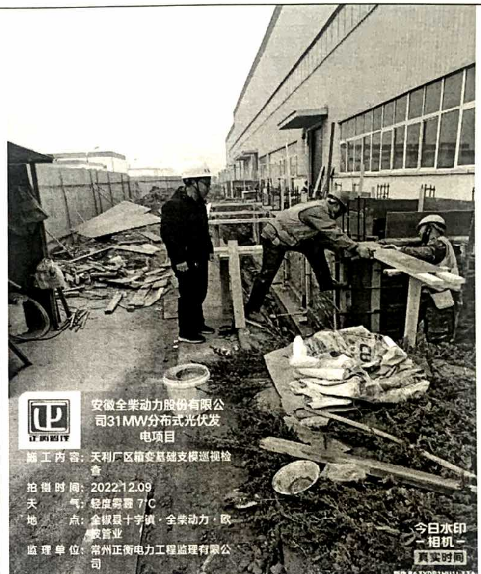
天利箱变基础支模检查
