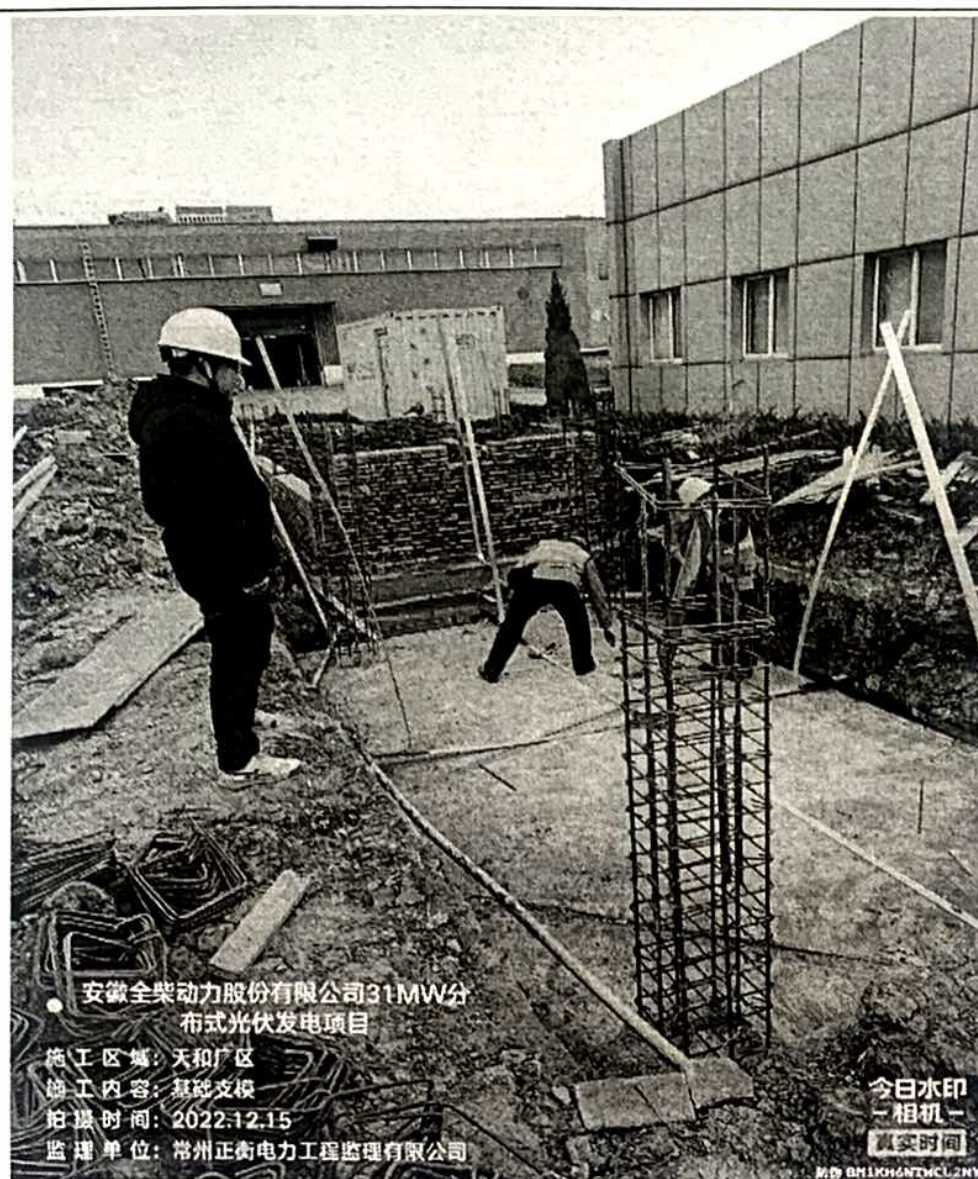
天和设备基础支模检查
