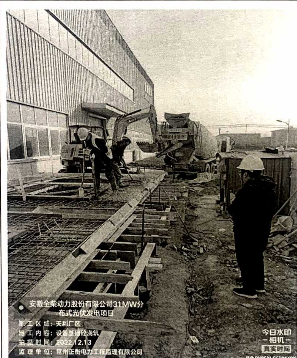
天利设备基础浇筑旁站
