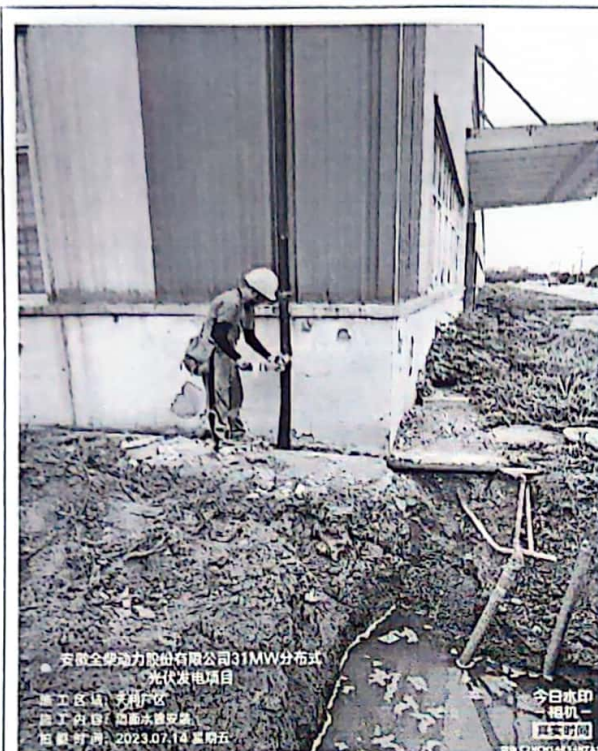
天利厂区清洗系统安装
