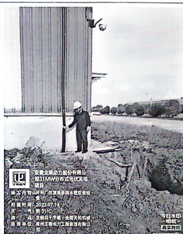
天利厂区清洗系统安装检查
