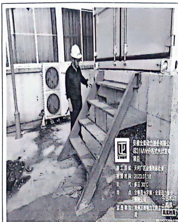
天利厂区爬梯安装检查
