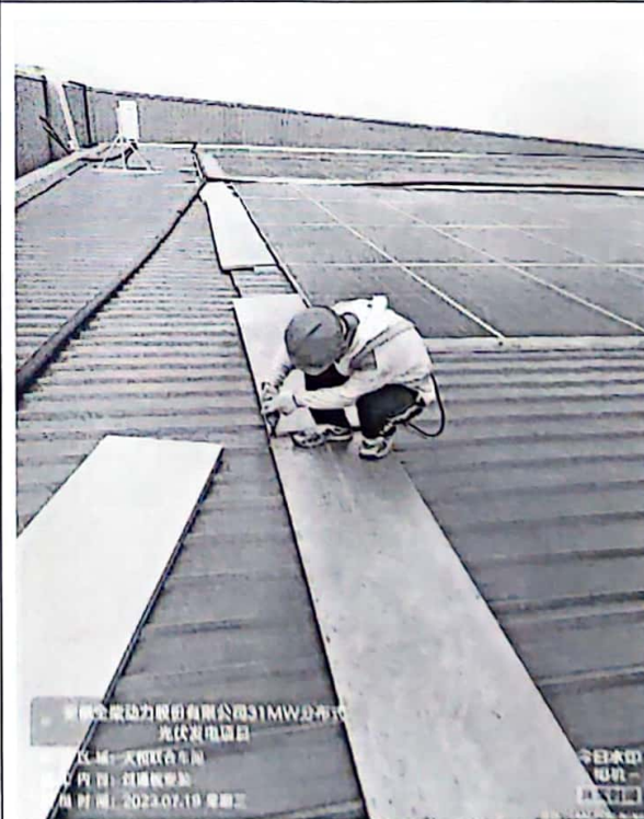
天和厂区联合车间过道板安装
