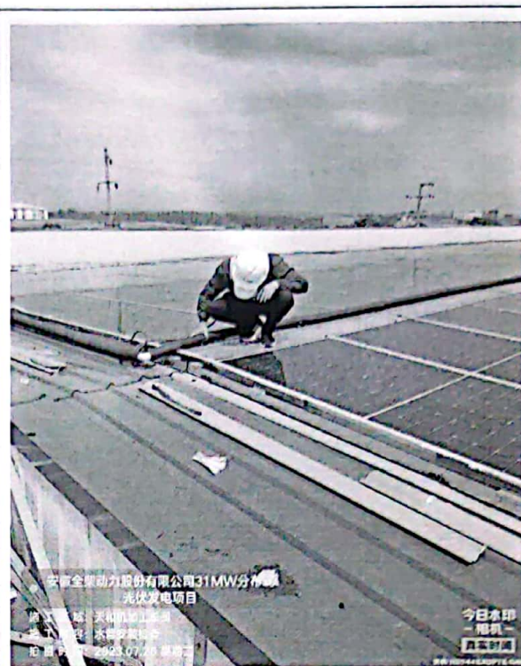
天和厂区清洗系统安装检查
