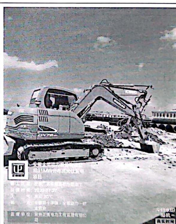
欧波厂区车棚基础挖掘施工
