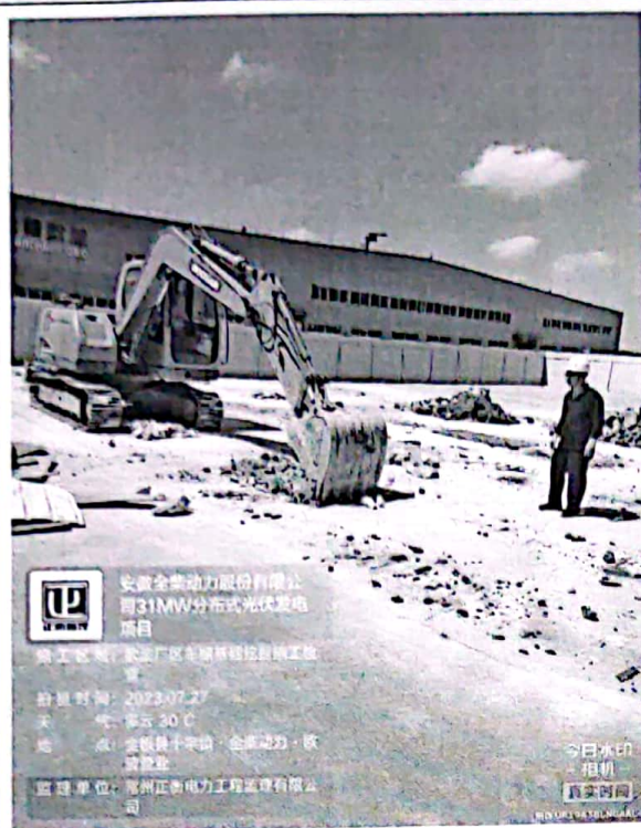
欧波厂区车棚基础挖掘施工检查
