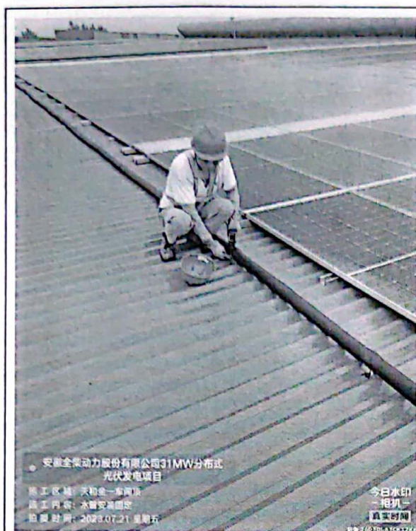
天和厂区清洗系统安装
