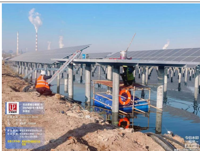
箱变平台安装检查
