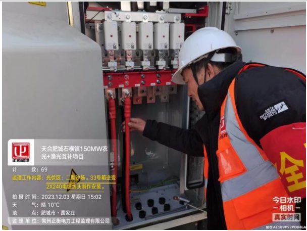
箱逆变一体机直流电缆头制作检查
