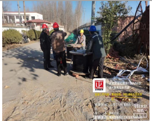
集电线路 485 通信电缆绽放
