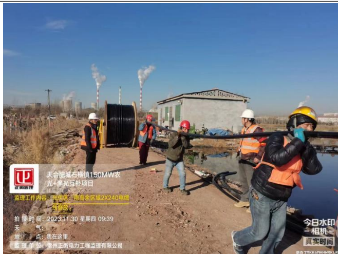
南高余施工区域 2x240 电缆展放
