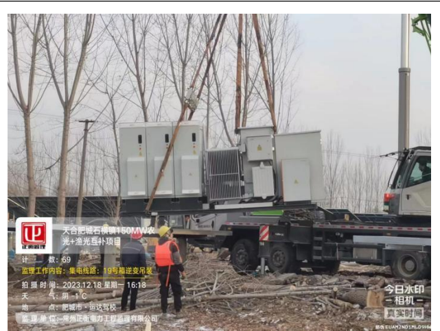
箱变一体机吊装
