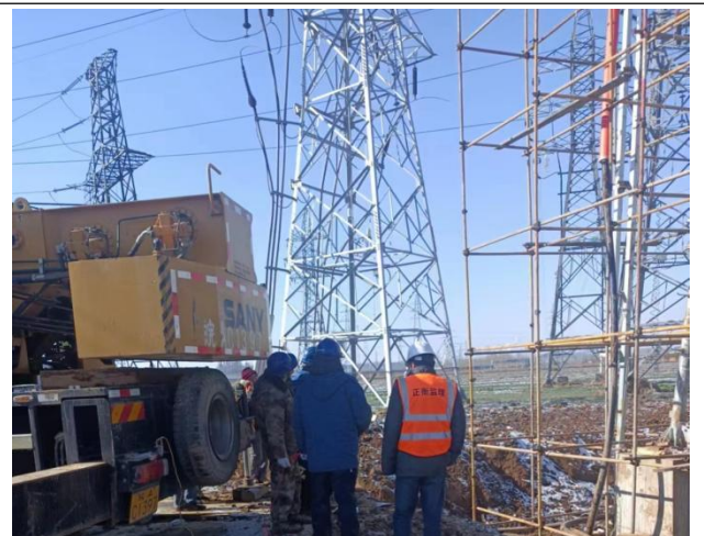
送出线路附件吊装
