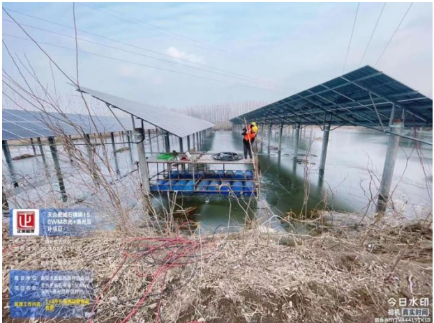
4 平方电缆接线
