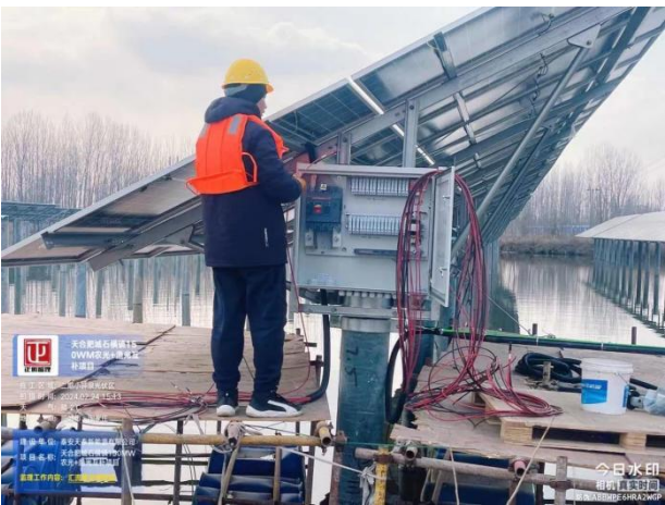
汇流箱接线安装
