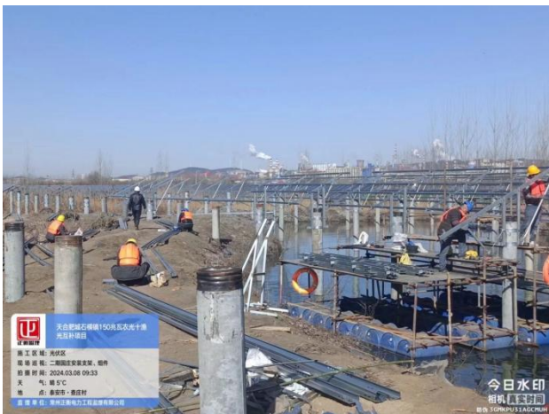
光伏区支架安装
