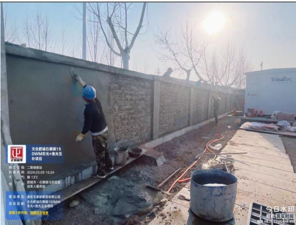
储能站围墙抹灰施工
