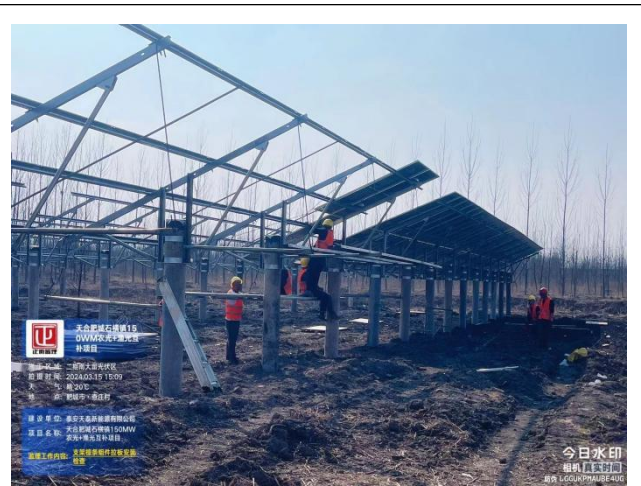
支架、组件安装
