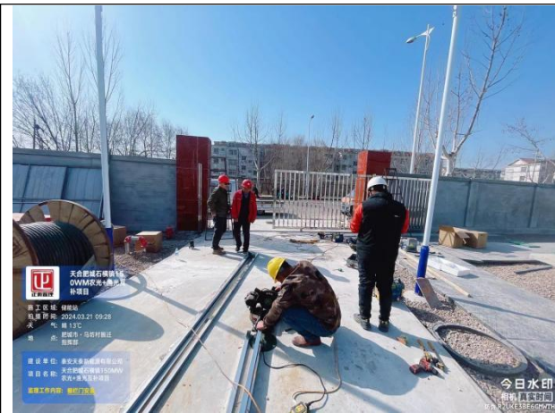
储能站大门安装
