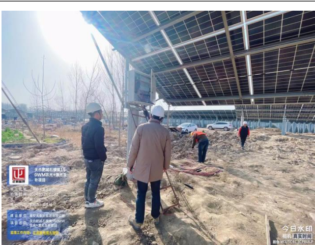
光伏区汇流箱安装检查
