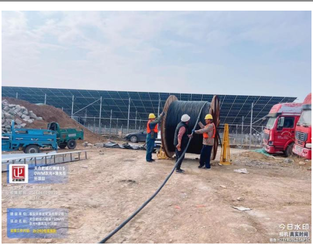
高压电缆敷设
