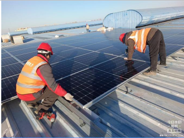
廊坊和平铝业光伏发电项目 施工内容: 组件安装 拍摄时间: 2022.12.27 15:14 天气: 晴 0℃ 监理单位: 常州正鼎电力工程监理有限公司
