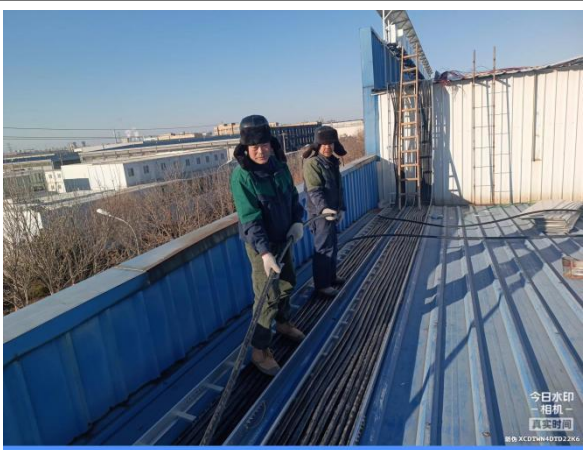
廊坊和平铝业光伏发电项目 施工内容: 电缆敷设 拍摄时间: 2022.12.29 14:40 天气: 晴 0℃ 监理单位: 常州正鼎电力工程监理有限公司
