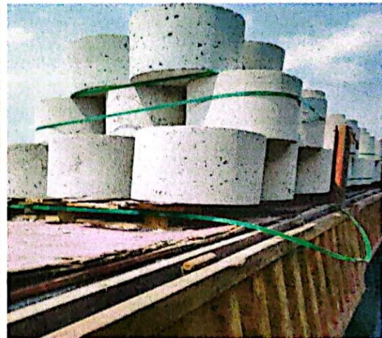
支墩进场卸车
