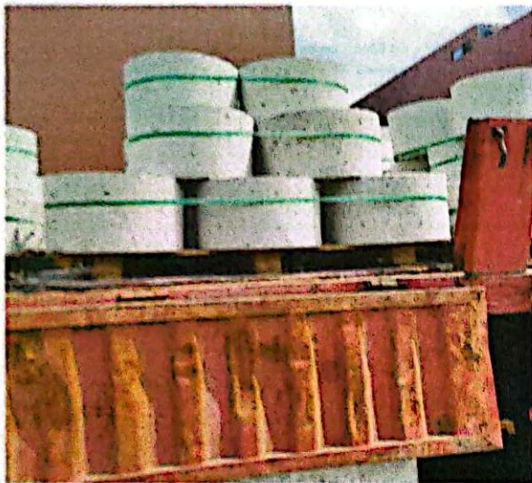
支架支墩进场
