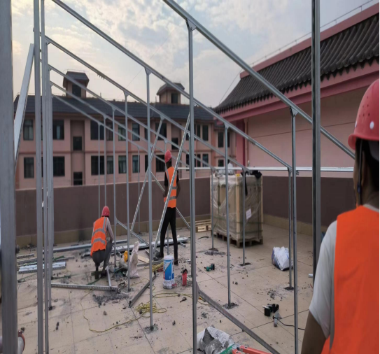
党校支架安装
