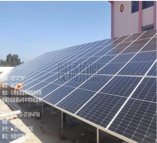
气象局组件安装
