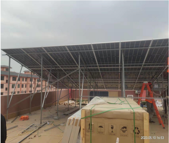
党校组件安装
