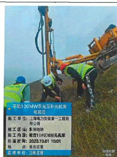
东郑区域 18#区域检查桩孔深
