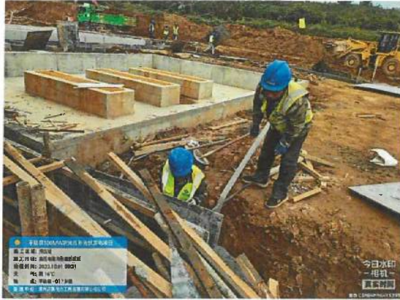
升压站电缆沟侧壁模板安装
