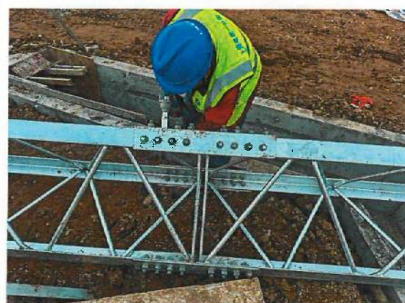
升压站构架横梁安装
