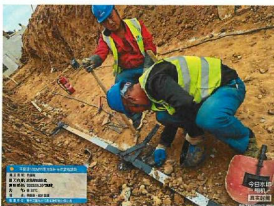
升压站接地扁铁焊接后刷防腐
