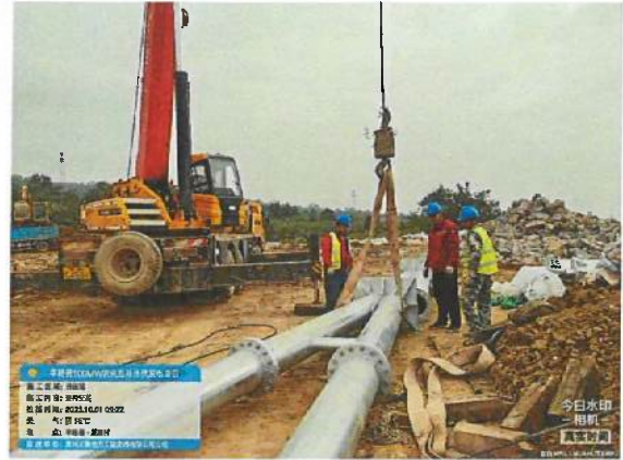
升压站构架安装
