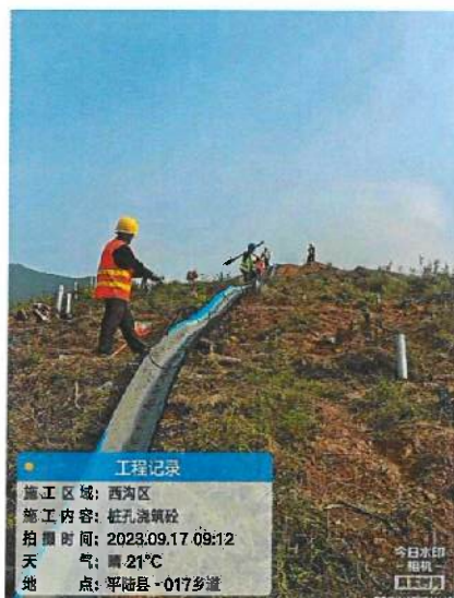
西沟区域桩基浇筑
