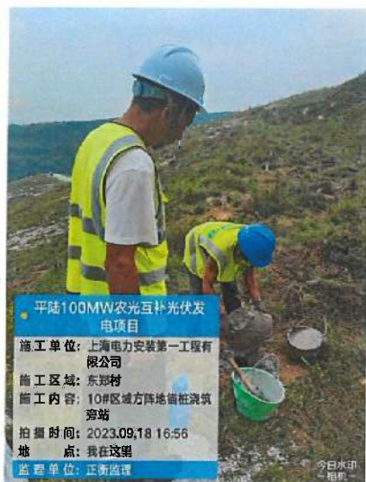
东郑区域 10#方阵地锚桩混凝土浇筑
