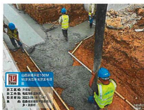
升压站电缆沟垫层混凝土浇筑
