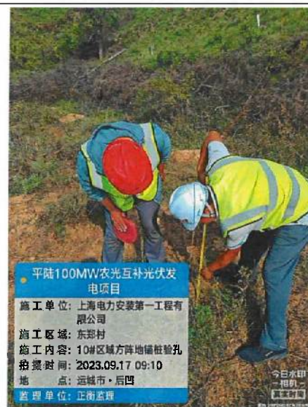
东郑区域 10#方阵地锚桩验孔
