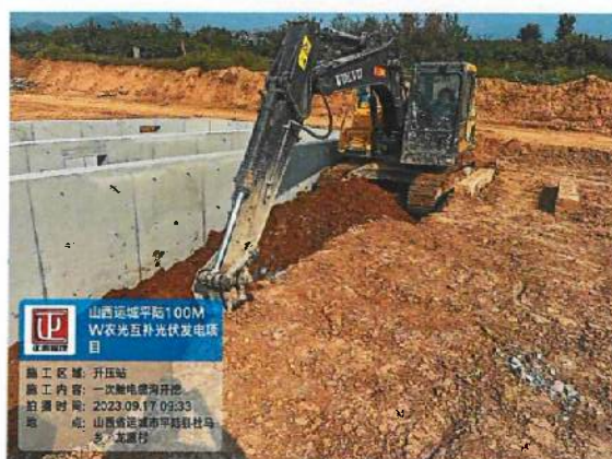
升压站场区内电缆沟开挖
