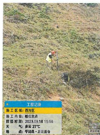
西沟区域桩位放点
