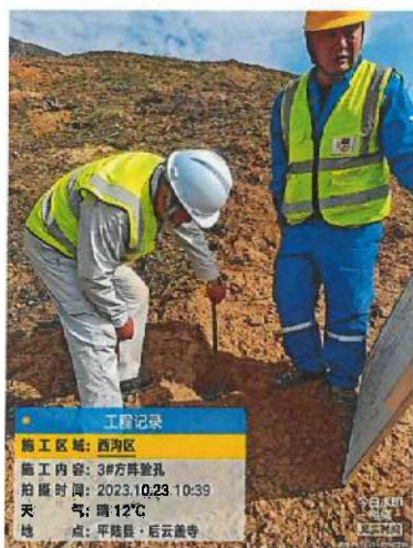
西沟区域 3#方阵桩基验孔
