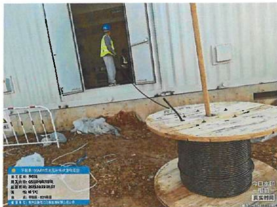
升压站 GIS 控制电缆敷设
