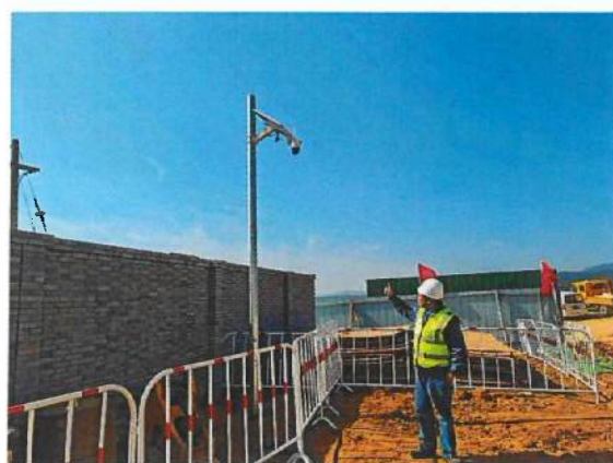
项目公司王轩升压站检查工作
