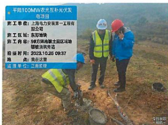
东郑区域桩基砼浇筑
