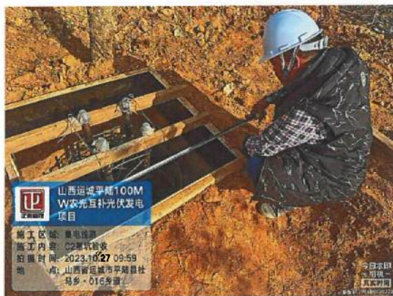
集电线路 C2 基坑验收
