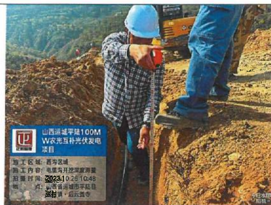
西沟区域电缆沟开挖深度测量
