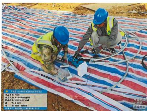
升压站钢芯铝绞线耐张头制作
