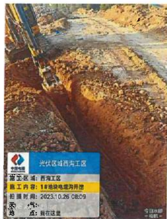
西沟区域电缆沟开挖
