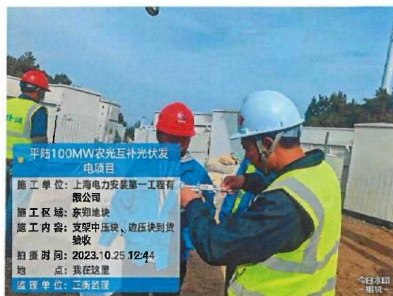
东郑区域 18#方阵地锚桩验孔
