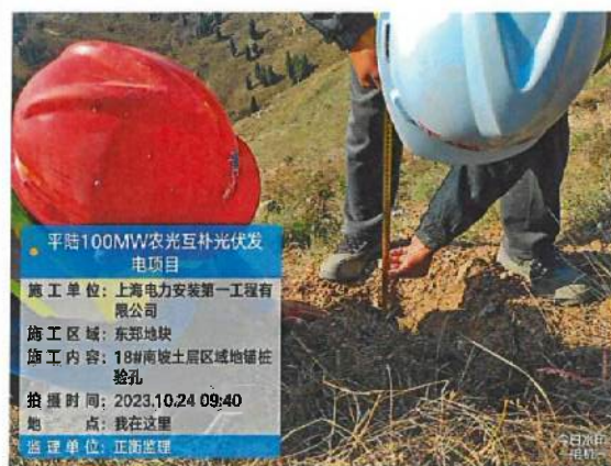
东郑区域 18#方阵地锚桩验孔
