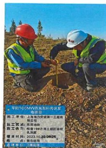
东郑区域 19#方阵桩基验孔
