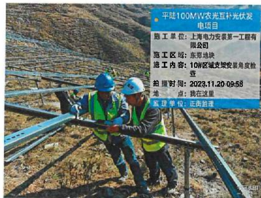
东郑区域 10#方阵支架安装角度检查
