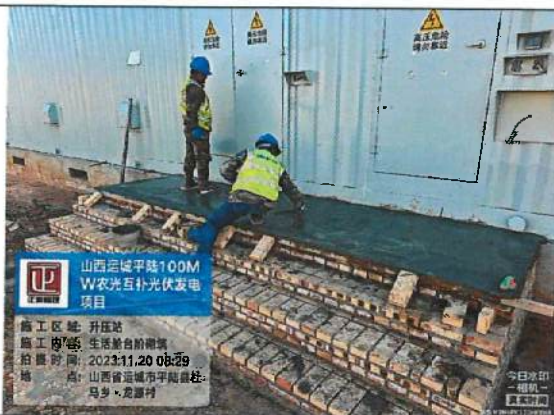
升压站生活舱台阶抹灰
