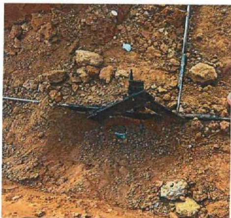
升压站环网接地验收
