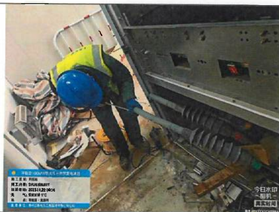
升压站 SVG 高压电缆头制作
