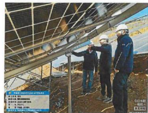
西沟区域组件安装检查
