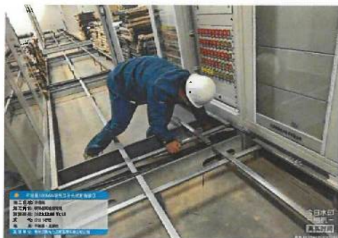
项目公司王轩升压站质量检查
