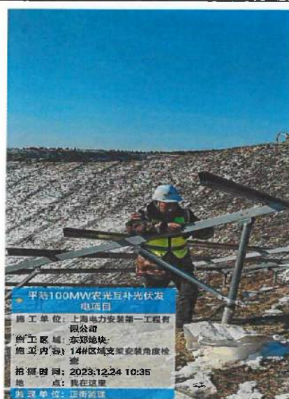
东郑区域 14#支架安装检查
