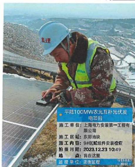
东郑区域 9#组件安装检查
