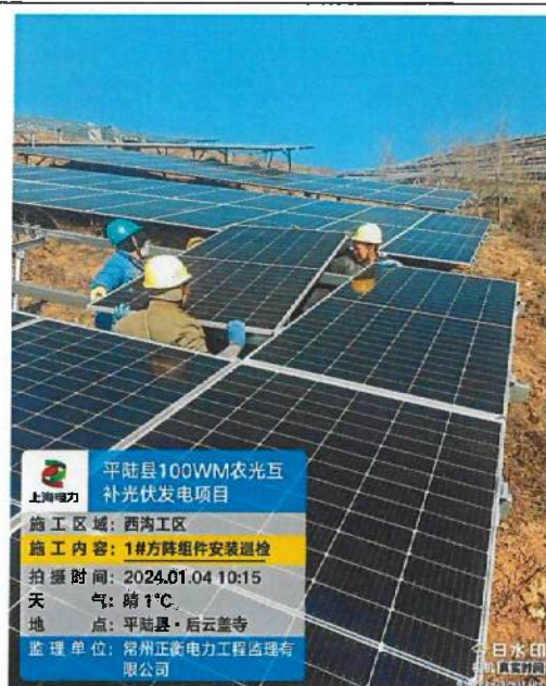
西沟区域 1#方阵组件安装
