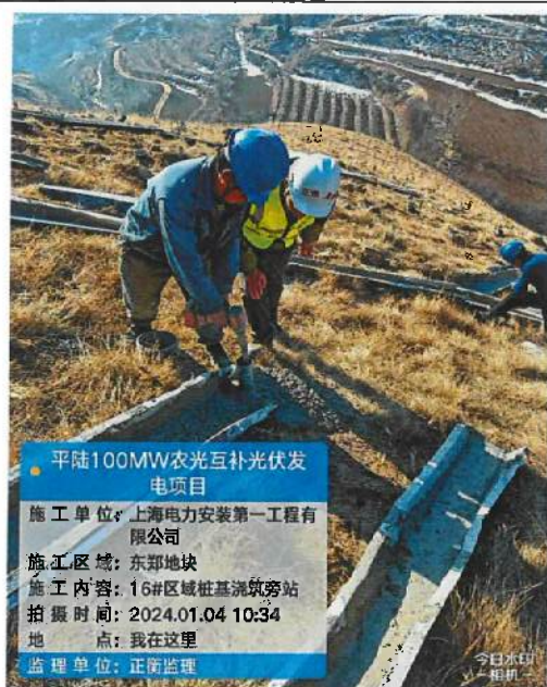
东郑区域 16#方阵桩基浇筑
