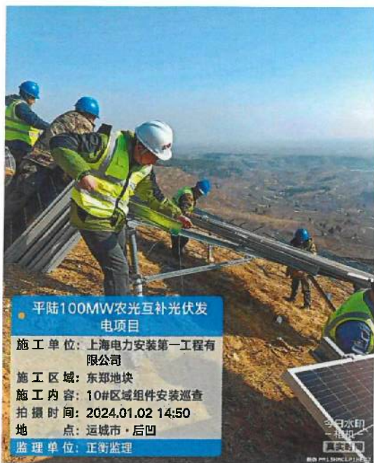
东郑区域 10#方阵组件安装质量检查
