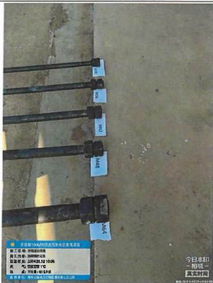
送出线路地脚螺栓取样送检
