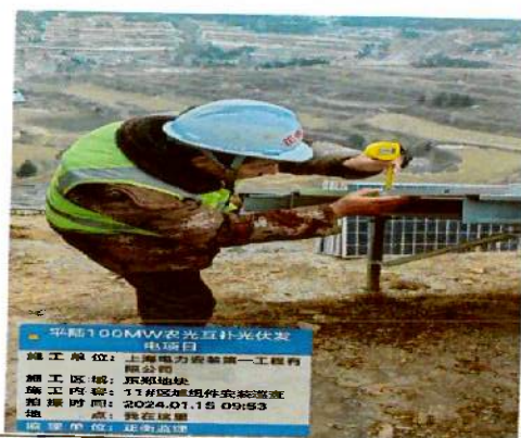
东郑区域 11#方阵组件安装质量检查
