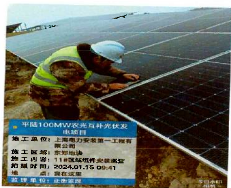
东郑区域 11#方阵组件安装质量检查
