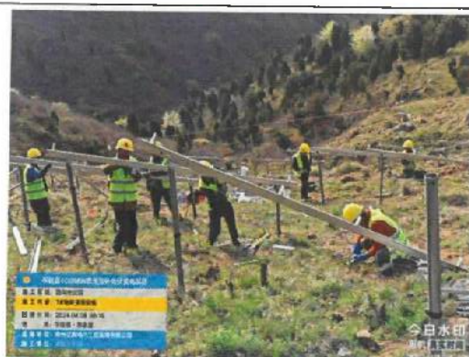
西沟区域 7#地块支架安装
