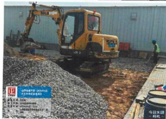
升压站设备区域碎石铺设
