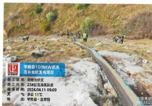
阳朝区域 23#桩基础浇筑
