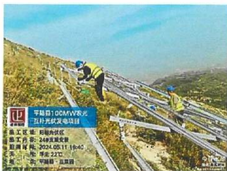
阳朝区域 24#地块支架安装
