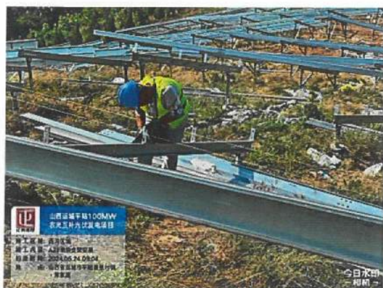
西沟区域 A2#地块支架安装
