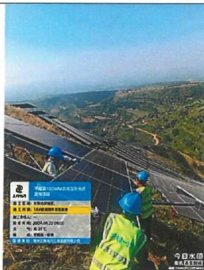
东郑区域 16#地块组件安装
