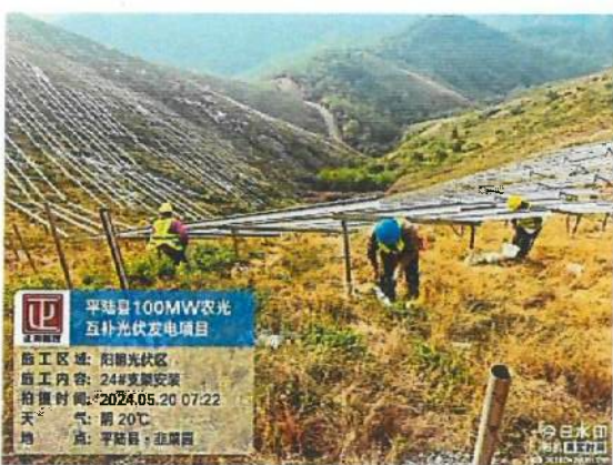
阳朝区域 24#地块支架安装
