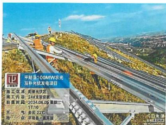
阳朝区域 24#地块支架安装
