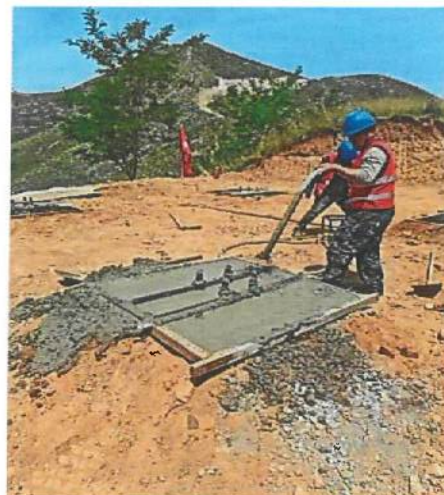
集电线路 XD31 混凝土浇筑
