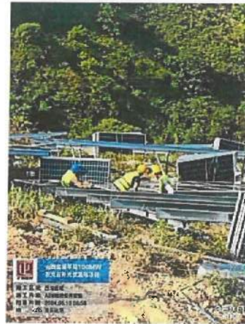
西沟区域 A2#地块组件安装
