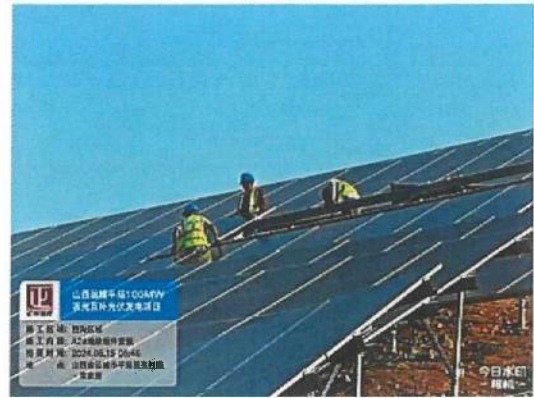
西沟区域 A2#地块组件安装
